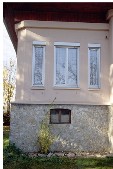
Façade antérieure : fenêtres du renforcement à gauche. Phot. Yves Sancey IVR43_19943901600ZA
