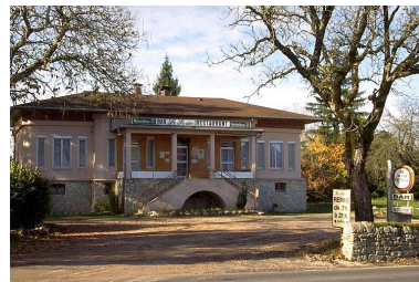
Vue d'ensemble. Phot. Yves Sancey IVR43_19943901596ZA
