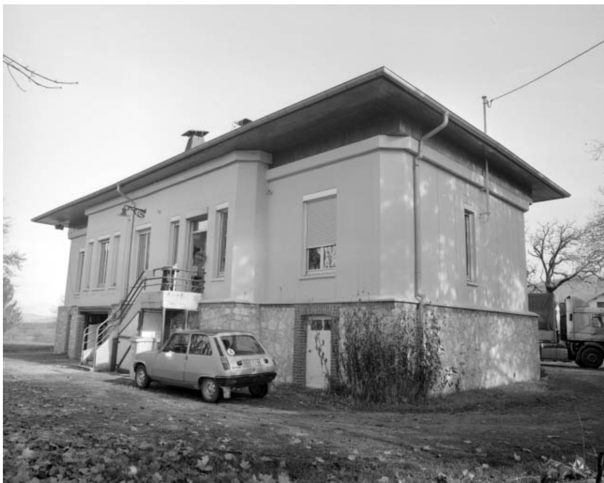
Façade postérieure vue de trois quarts droite.
