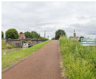
Vue du pont et du site.
