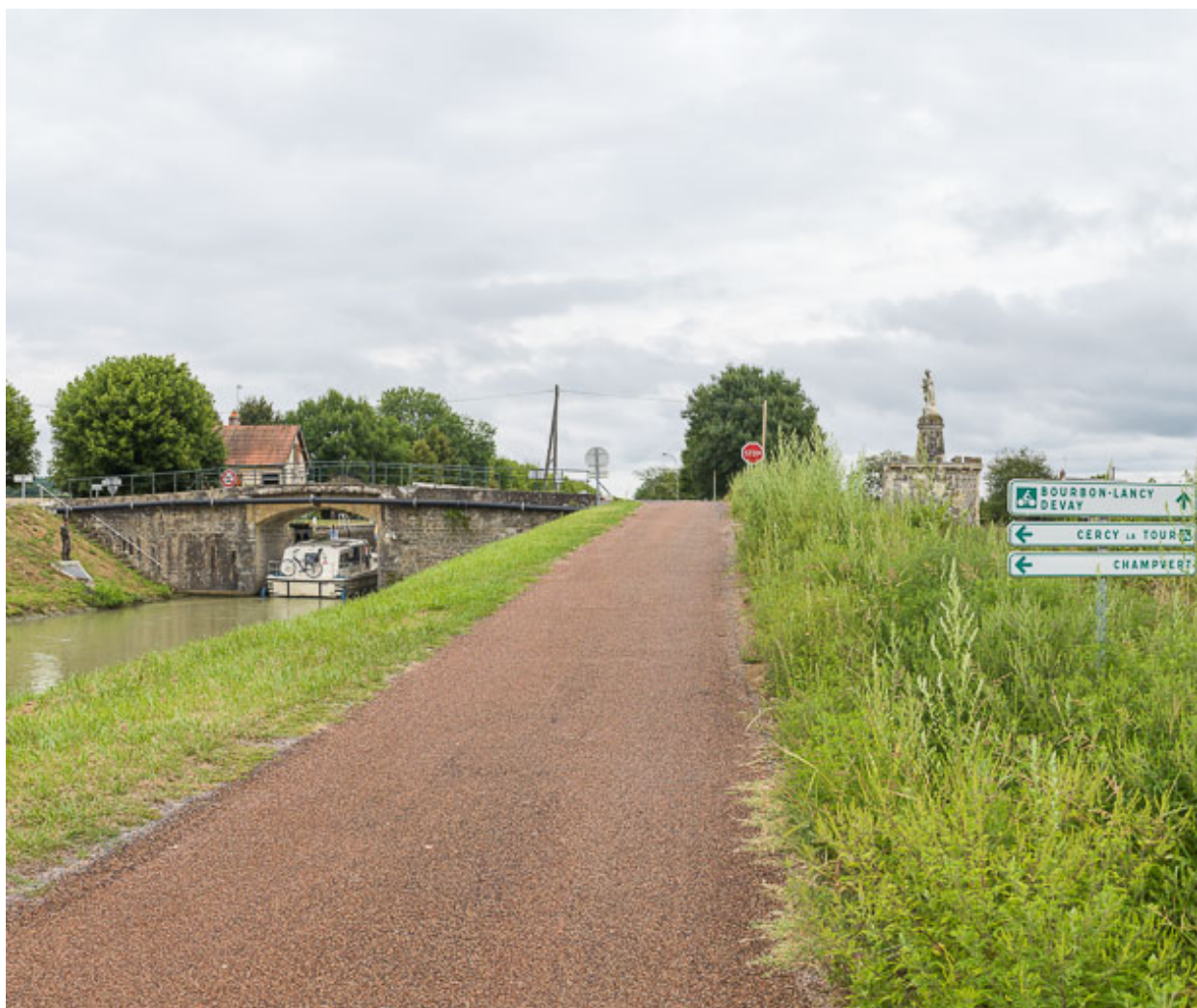
Vue du pont et du site.
