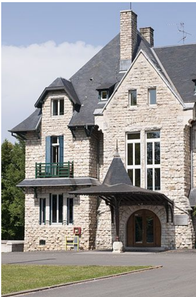
Partie nord de la façade antérieure.
