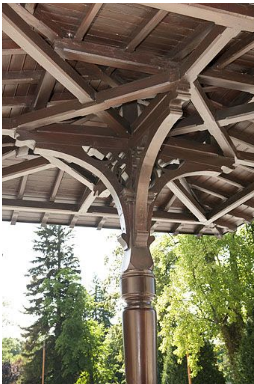
Façade antérieure. Marquise en bois
