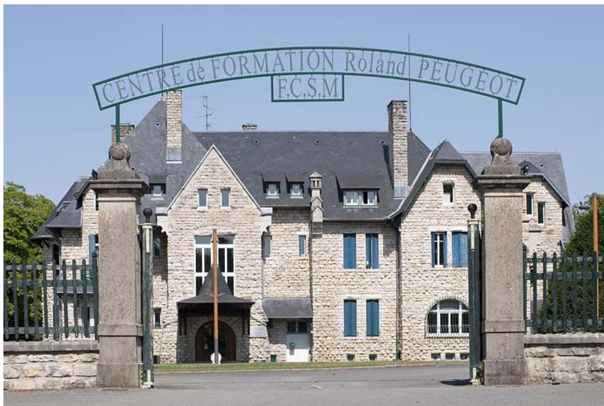
Vue d'ensemble depuis l'entrée.
