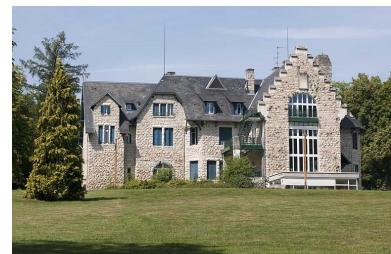
Façade postérieure depuis le sud-est.
