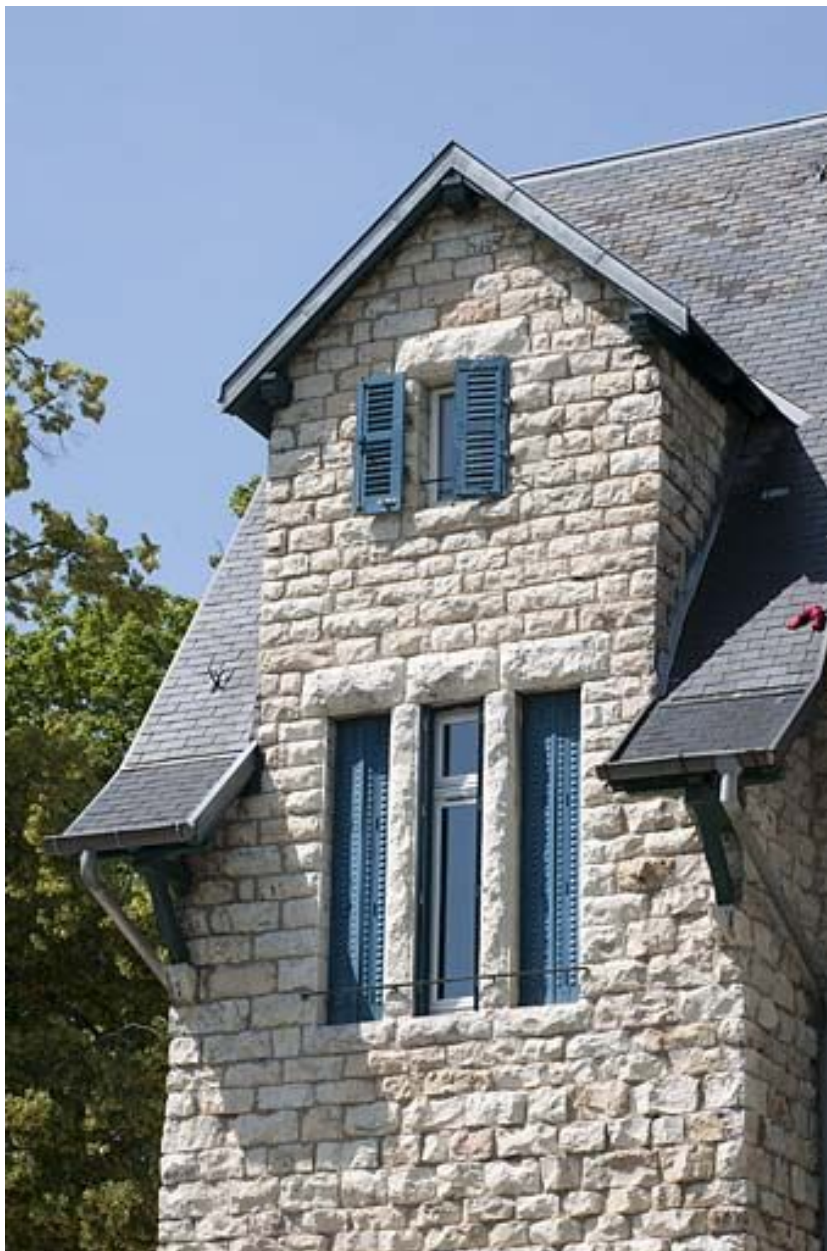
Façade postérieure. Pignon sud.
