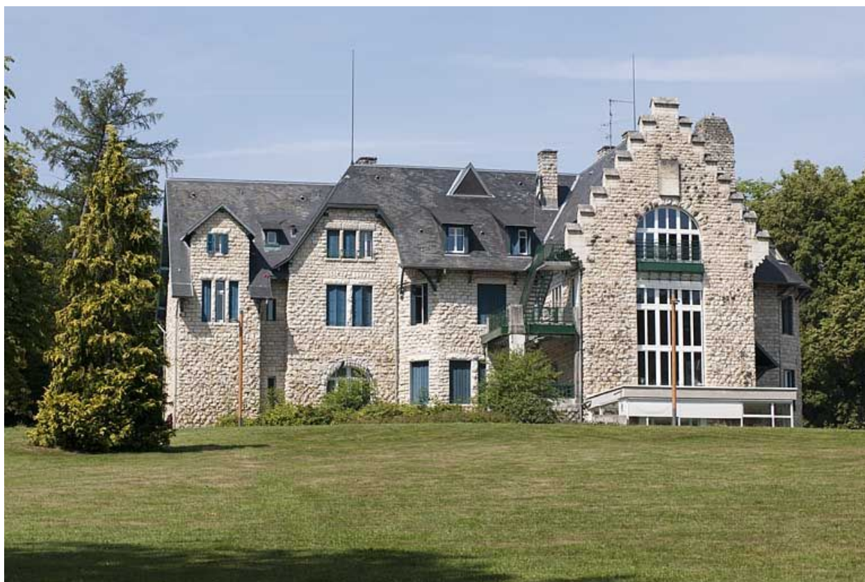
Façade postérieure depuis le sud-est.
