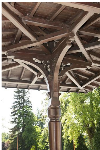
Façade antérieure. Marquise en bois Phot. Jérôme Mongreville IVR43_20112501510NUC4A
