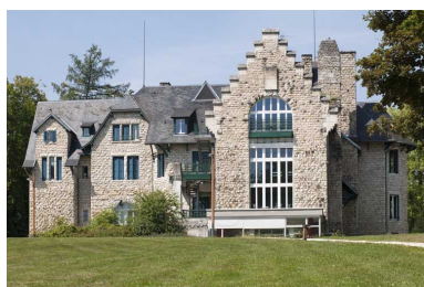
Façade postérieure depuis l'est. Phot. Jérôme Mongreville IVR43_20112501491NUC4A
