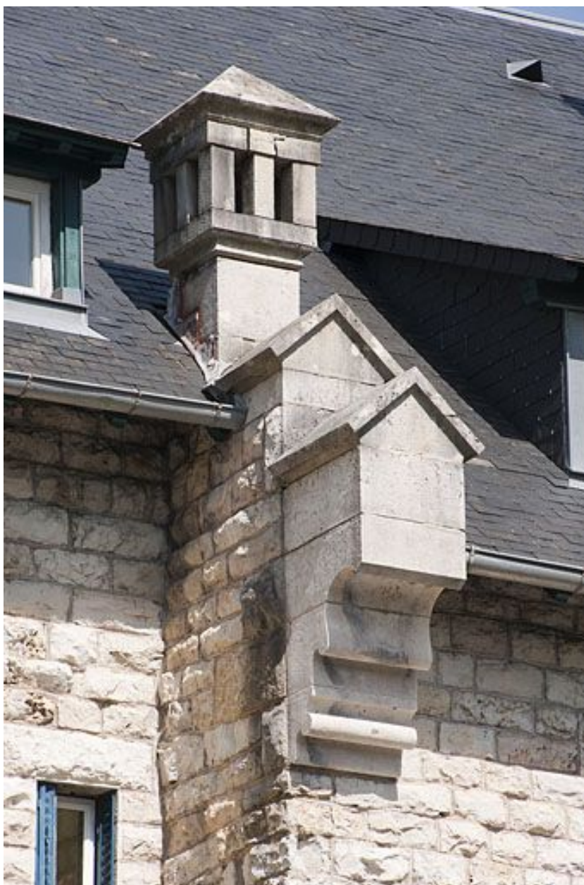
Façade antérieure. Détail d'une console.
