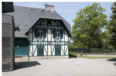
Conciergerie. Pignon nord de la façade postérieure. Phot. Jérôme Mongreville IVR43_20112501499NUC4A
