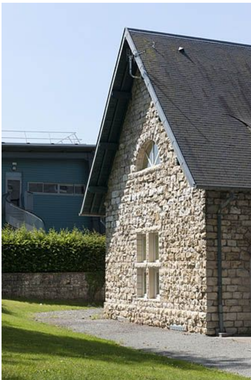
Conciergerie. Pignon sud de la façade postérieure.
