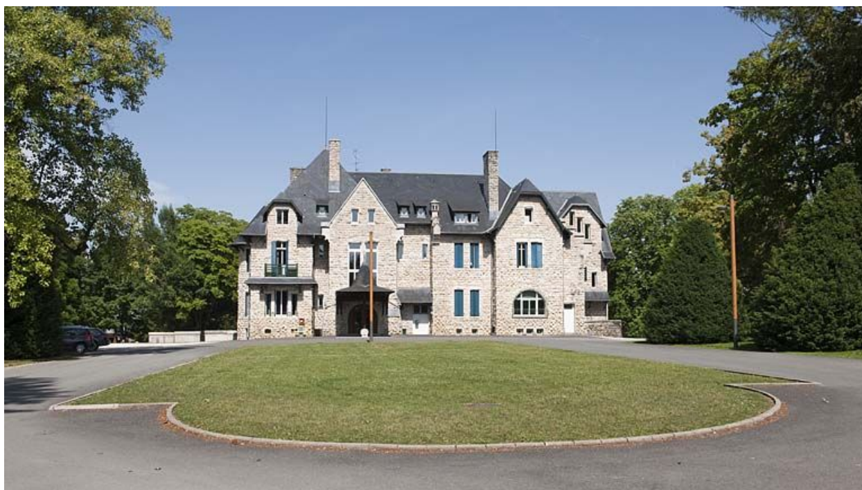
Façade antérieure depuis l'entrée.
