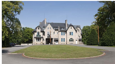
Façade antérieure depuis l'entrée.
