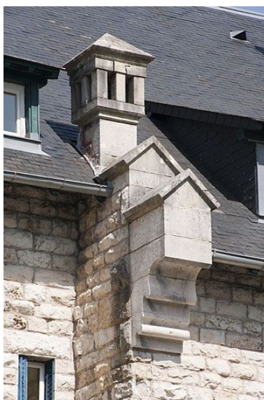
Façade antérieure. Détail d'une console. Phot. Jérôme Mongreville IVR43_20112501508NUC4A
