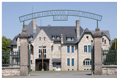
Vue d'ensemble depuis l'entrée.
