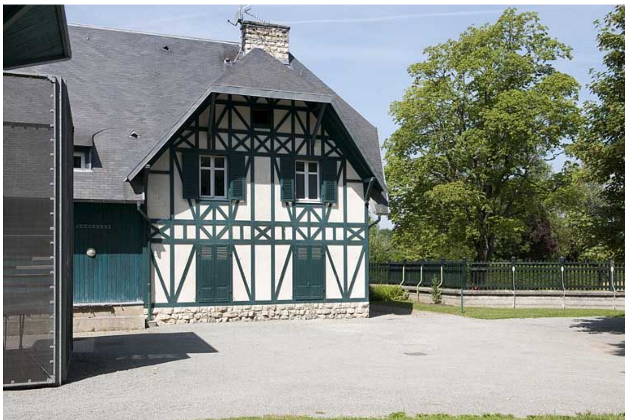
Conciergerie. Pignon nord de la façade postérieure.
