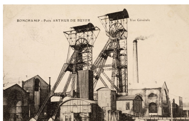
Ronchamp - Puits Arthur de Buyer - Vue générale. Phot. Jérôme Mongreville IVR43_20057000606NUCA
