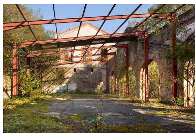
Salle des chaudières. Phot. Jérôme Mongreville IVR43_20077000586NUCA
