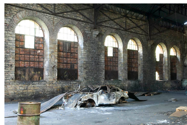
Mur nord du bâtiment des vestiaires. Phot. Jérôme Mongreville IVR43_20077000589NUCA
