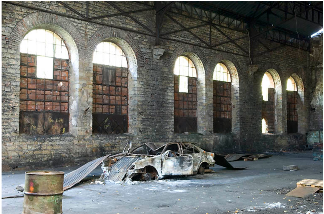
Mur nord du bâtiment des vestiaires.
