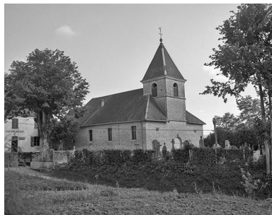
Extérieur : façade antérieure et face gauche. Phot. Yves Sancey IVR43_19843900141X
