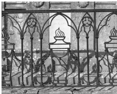
Détail de la clôture. Phot. Yves Sancey IVR43_19907000088X
