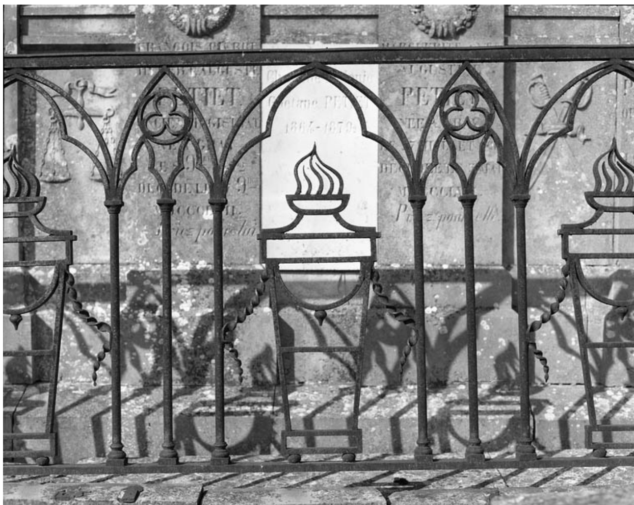
Détail de la clôture.
