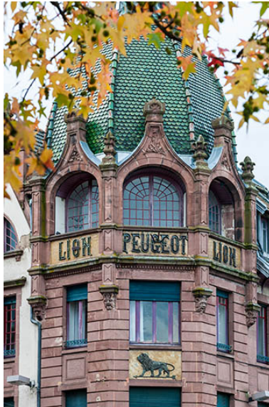
Immeuble Peugeot, 37 rue Cuvier à Montbéliard. Phot. Jérôme Mongreville IVR43_20132502796NUC4A
