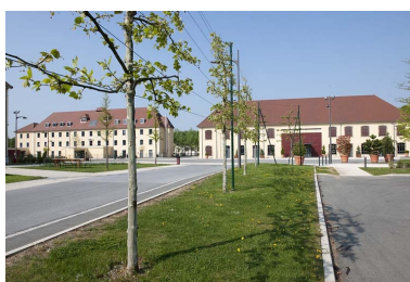
Usine textile Japy à Audincourt. Phot. Jérôme Mongreville IVR43_20112501139NUC4A
