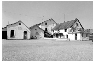
Pignons des ateliers depuis la cour. Phot. Yves Sancey IVR43_20009000253X
