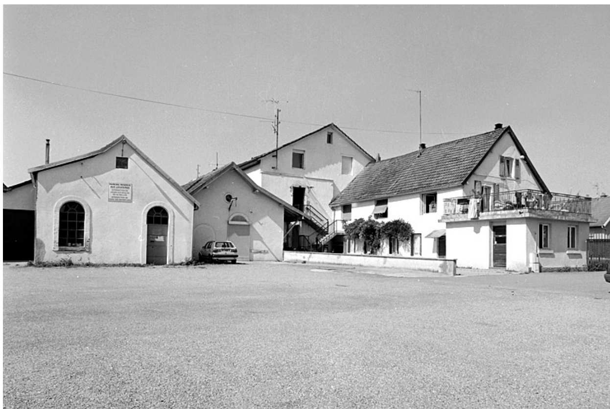
Pignons des ateliers depuis la cour.
