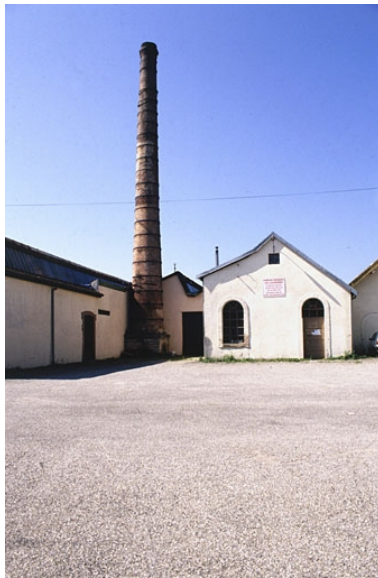
Cheminée et salle des machines. Phot. Yves Sancey IVR43_20009000259ZA
