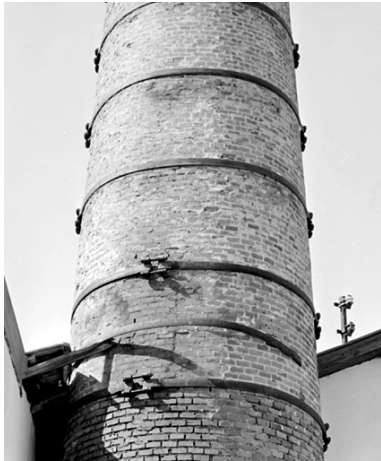
Détail de la cheminée : cerclages métalliques. Phot. Yves Sancey IVR43_20009000262X
