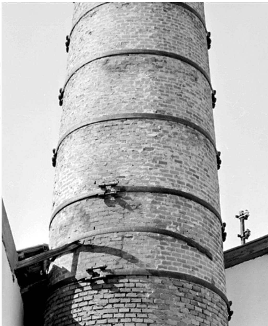
Détail de la cheminée : cerclages métalliques.
