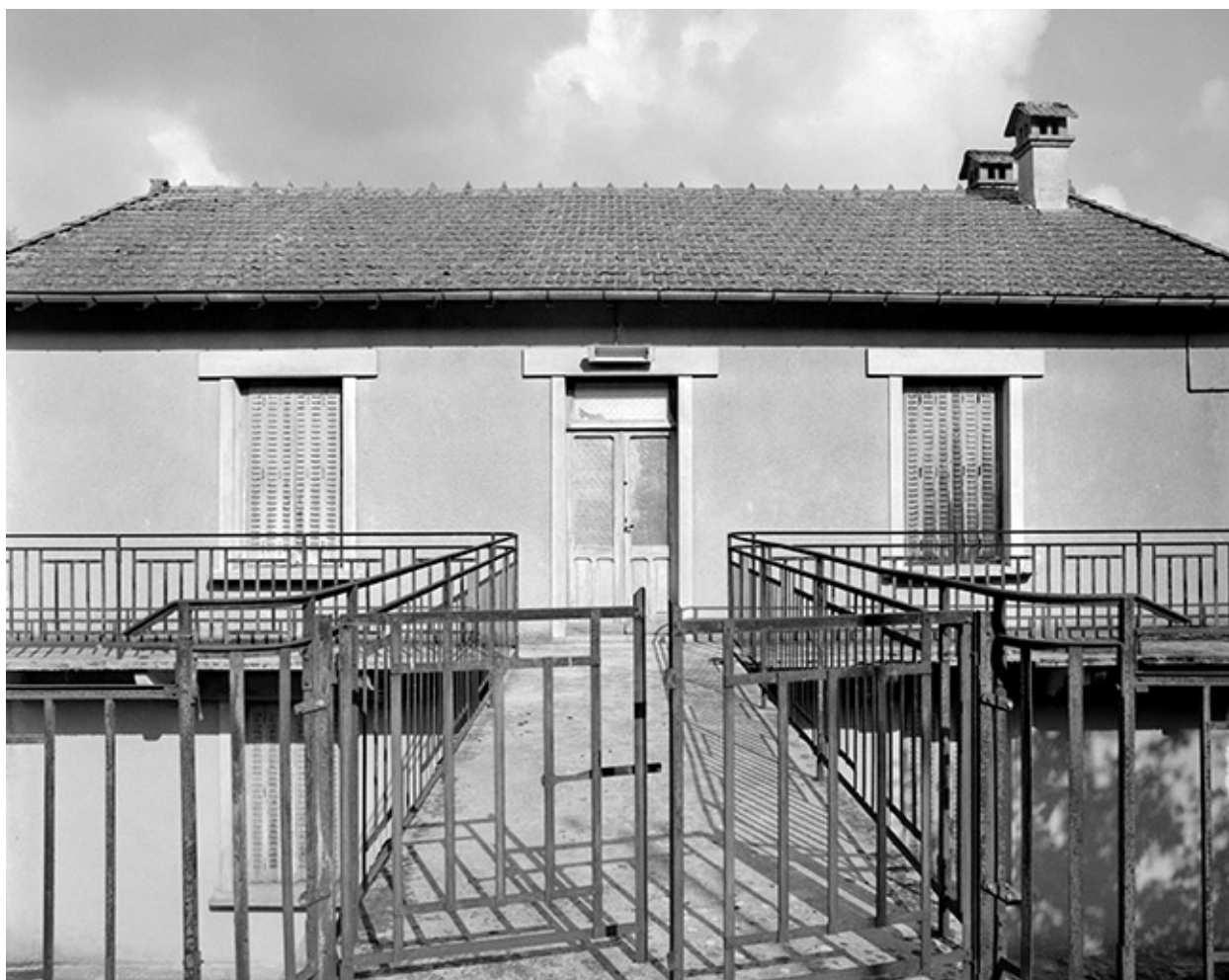
Façade antérieure du logement d'ouvriers.
