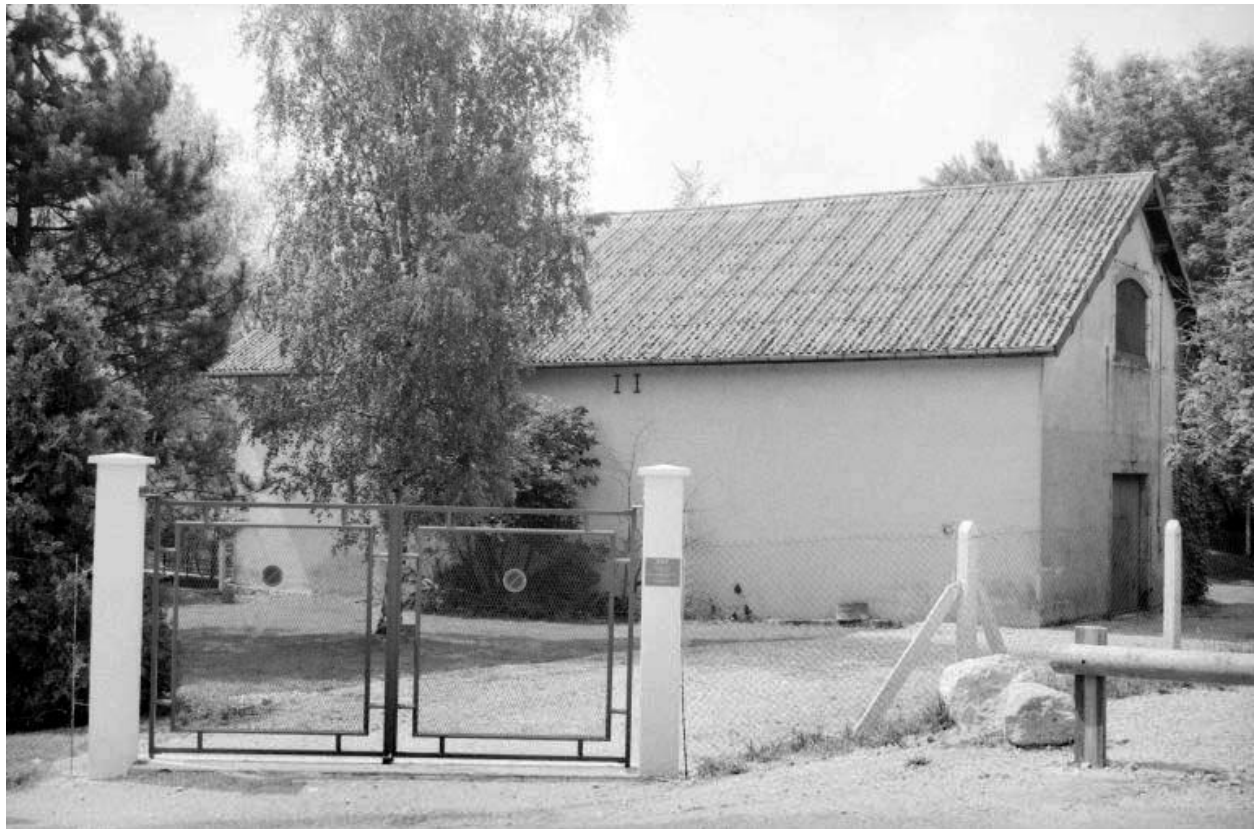
Bâtiment de prise d'eau.
