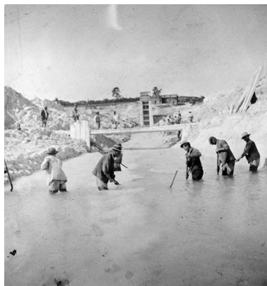
Prise d'eau vue d'amont [délayage de la marne]. Phot. Jérôme Mongreville IVR43_19913900222X
