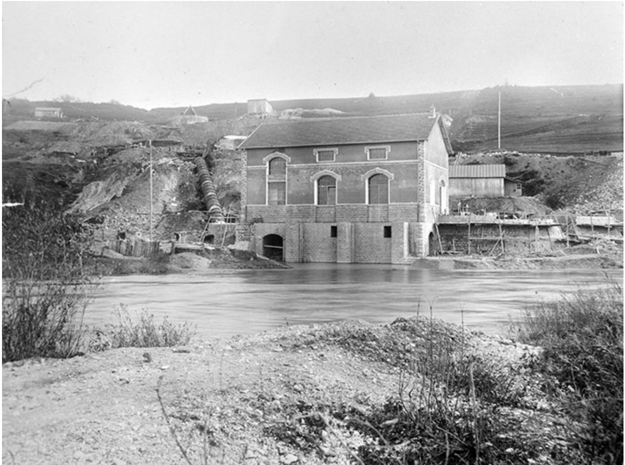
Centrale et conduite forcée en cours d'achèvement.
