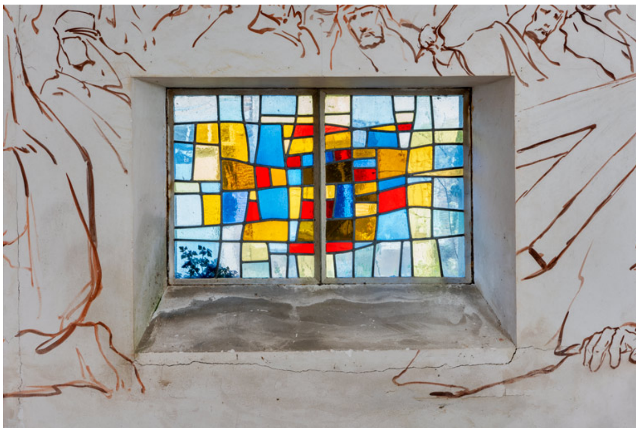
Vue d'une verrière (baie 1).
