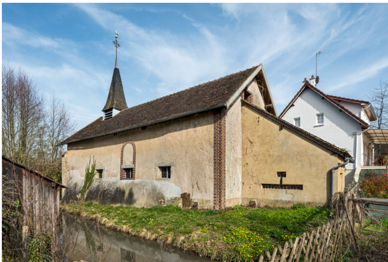
Vue de la façade nord.
