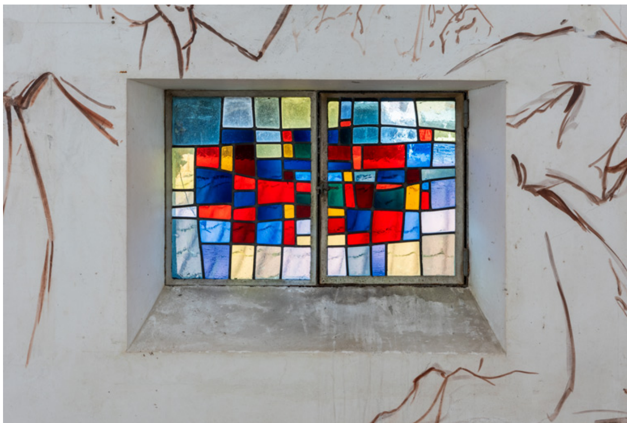
Vue d'une verrière (baie 5).
