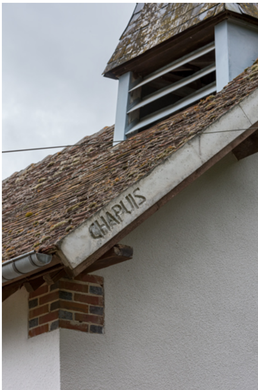
Rampant et rive de la toiture (détail).
