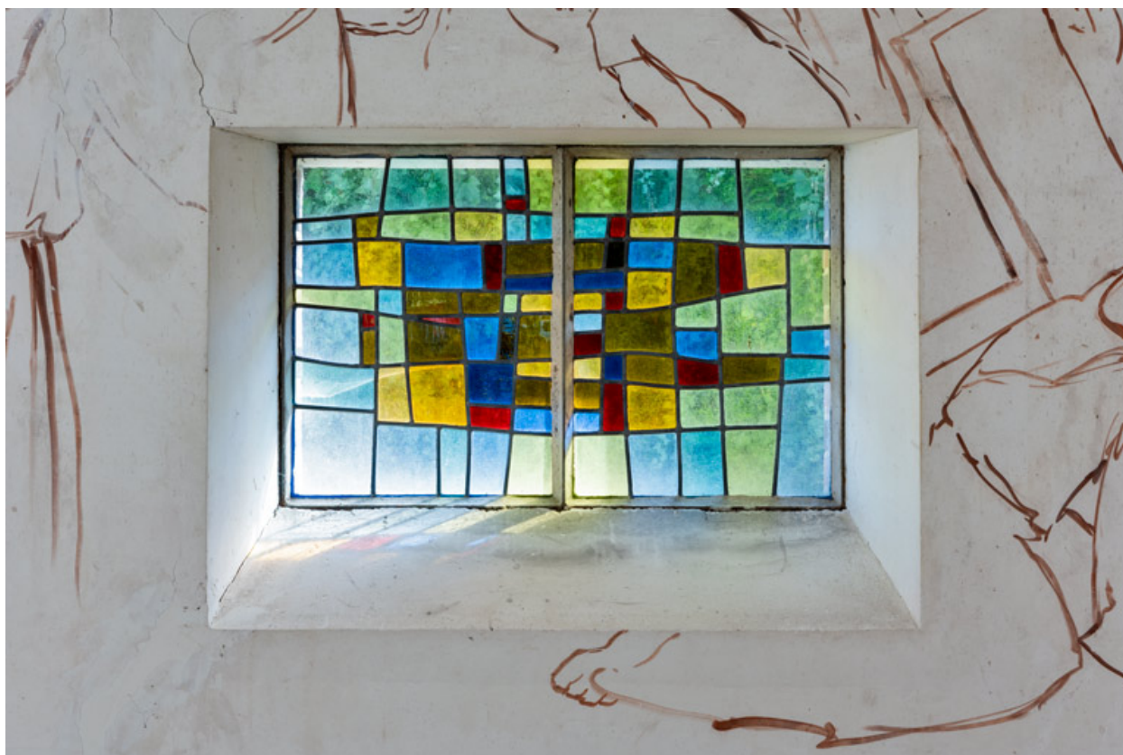
Vue d'une verrière (baie 2).
