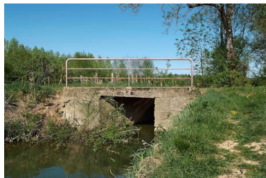
Vue d'ensemble. Phot. Jean-Luc Duthu IVR26_20107100555NUC2A
