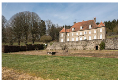
Façade antérieure (sud) du château. Phot. Sonia Dourlot IVR43_20177000537NUC4A
