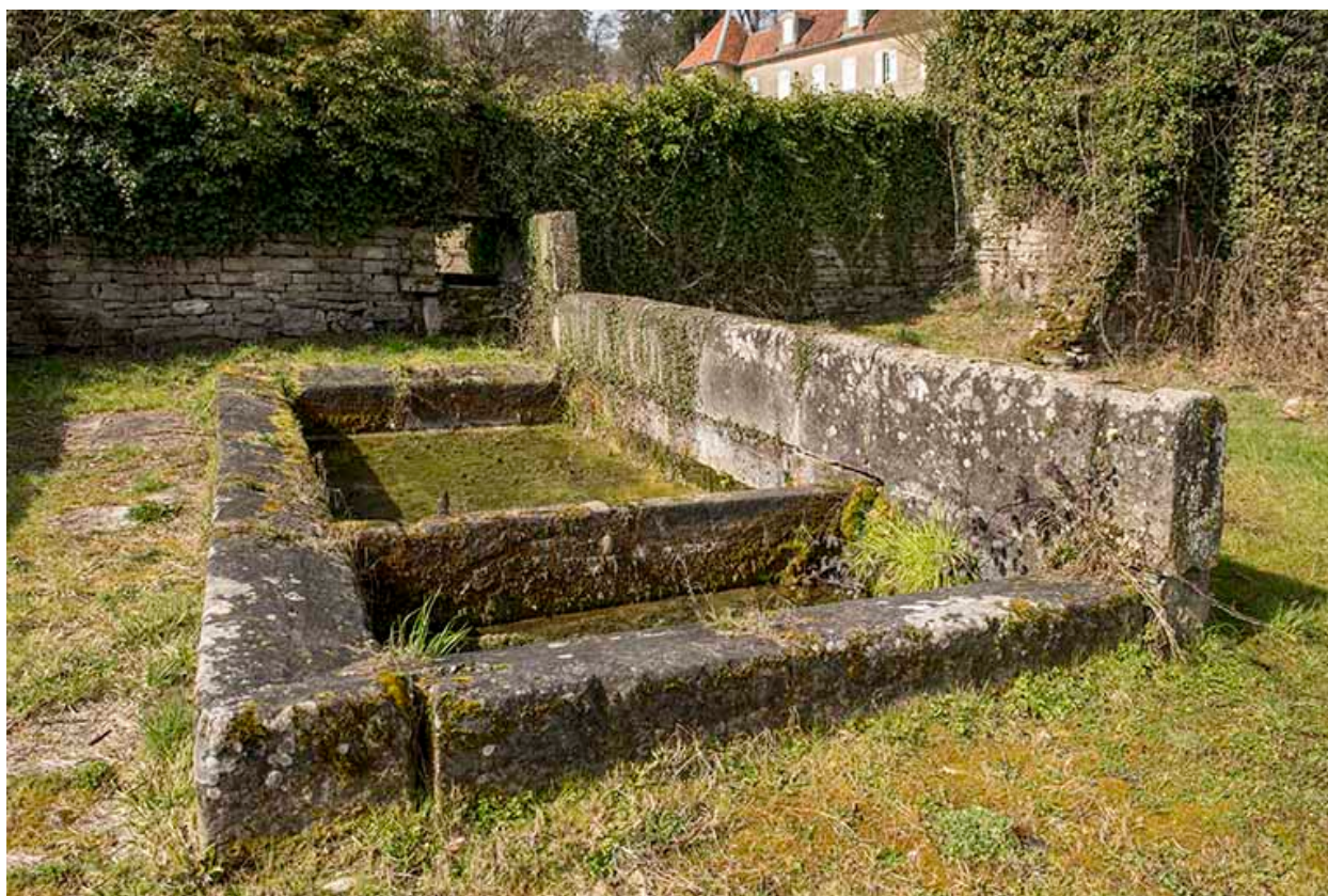
vue de l'est de l'ancien lavoir.
