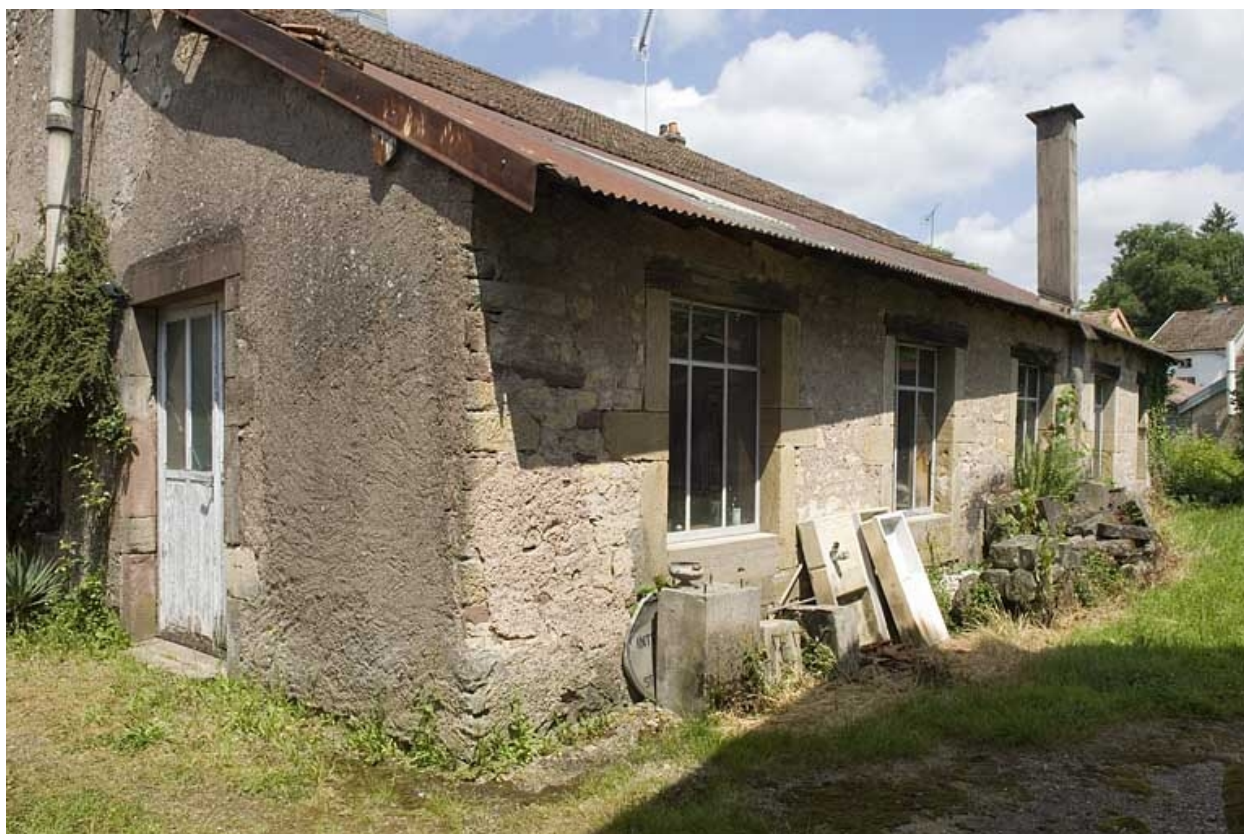
Façade sud de l'ancien moulin.
