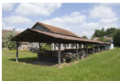
Entrepôt industriel (séchage et stockage du bois). Phot. Jérôme Mongreville IVR43_20097000435NUC2A
