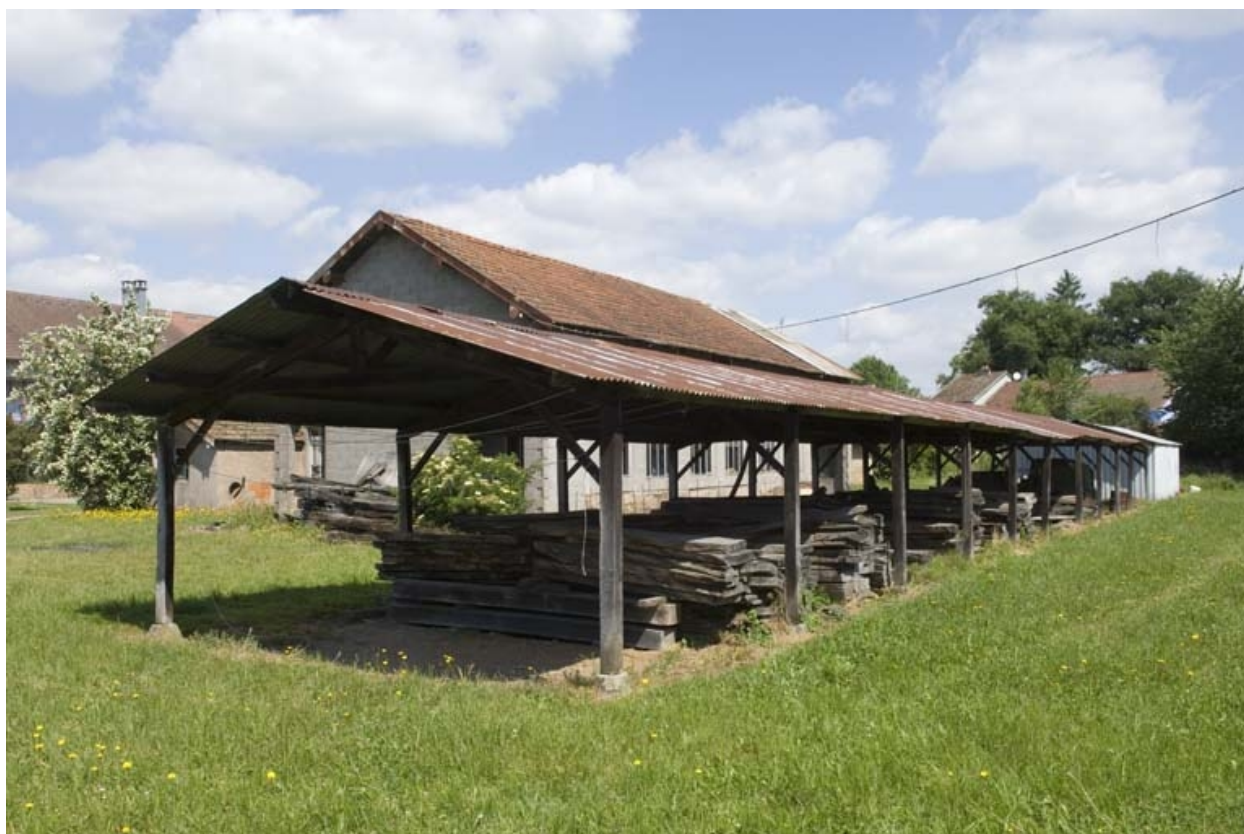
Entrepôt industriel (séchage et stockage du bois).
