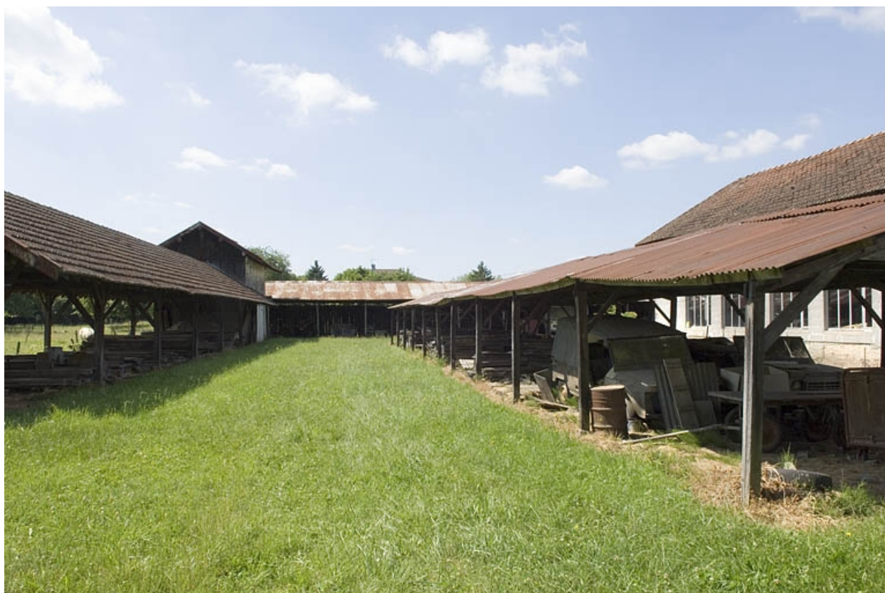
Entrepôts industriels sud.
