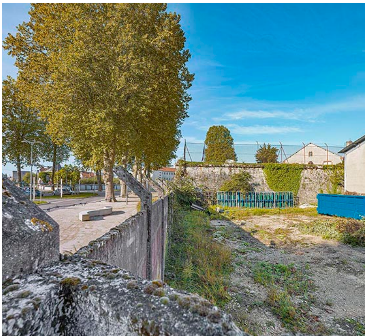
La face est du bastion.
