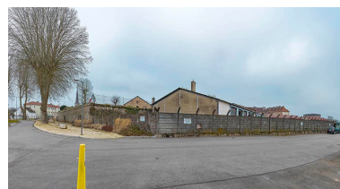
Vue sur la partie saillante du bastion. Phot. Thierry Kuntz IVR26_20242100103NUC4A
