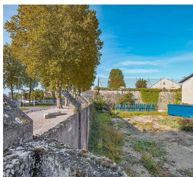
La face est du bastion. Phot. Thierry Kuntz IVR26_20232100392NUC4A
