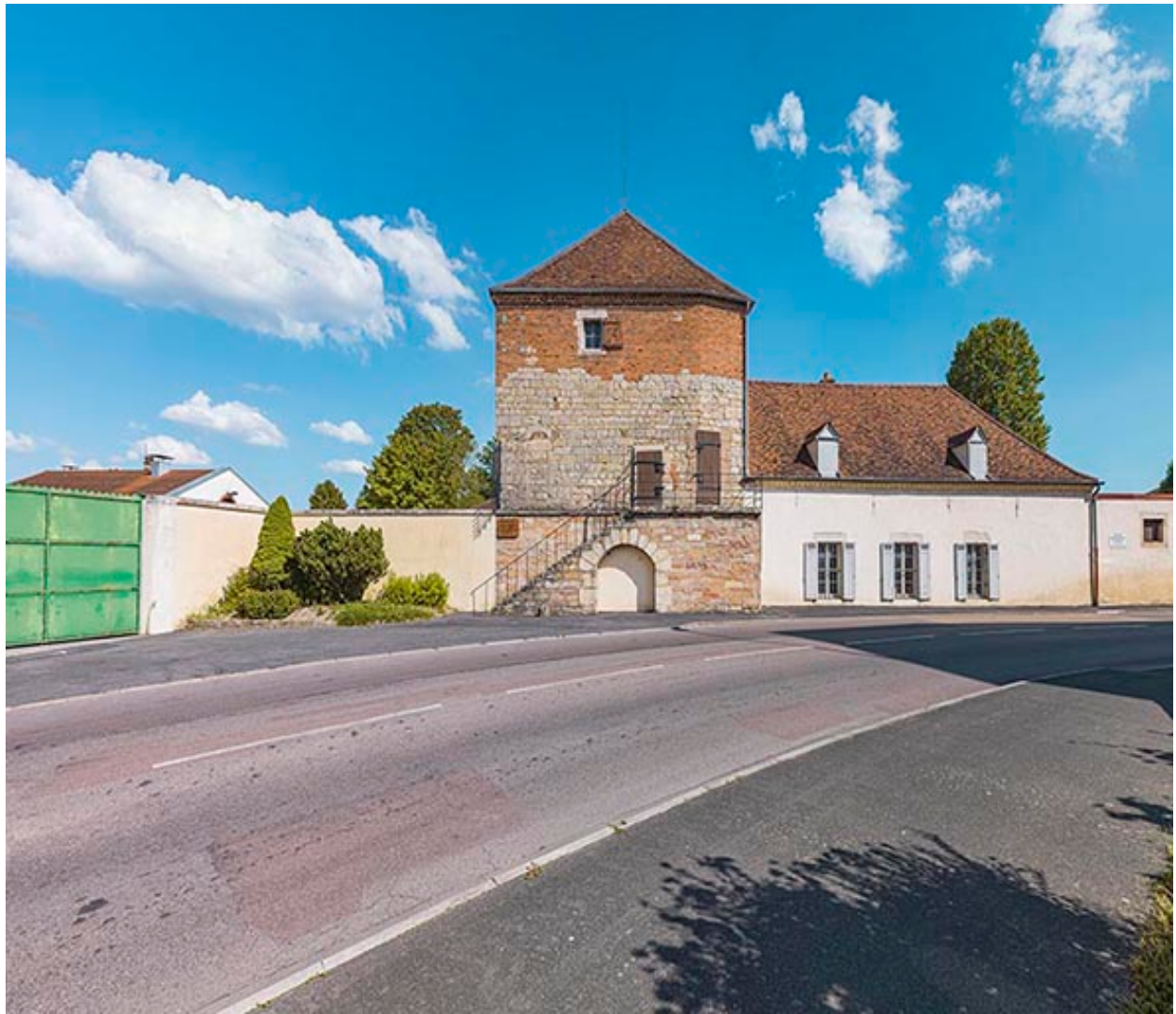
La tour Belvoir, face côté gorge.
