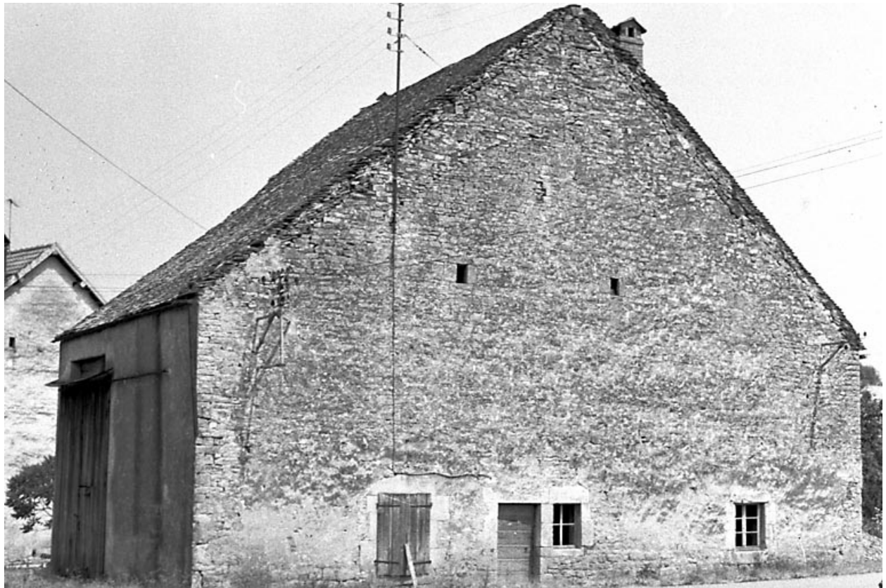
Ferme située Grande Rue (détruite entre 1976 et 2019).
