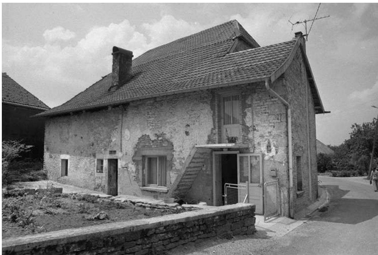
Ferme cadastrée 1965 ZM 103 : vue générale.
