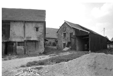
Ferme cadastrée 1965 ZM 102 : vue d'ensemble. Phot. Gilbert Poinot IVR43_19762500839Z
