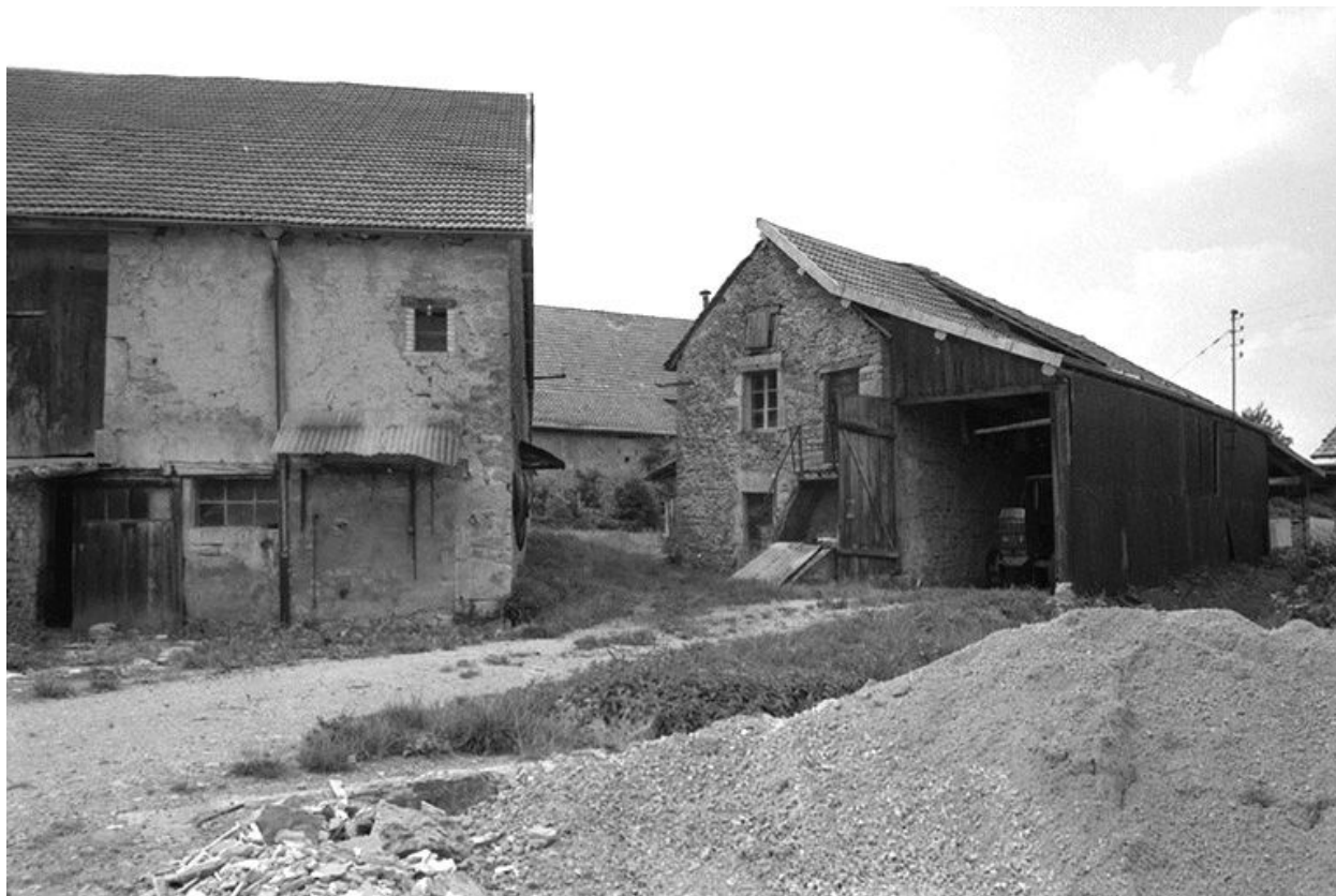
Ferme cadastrée 1965 ZM 102 : vue d'ensemble.
