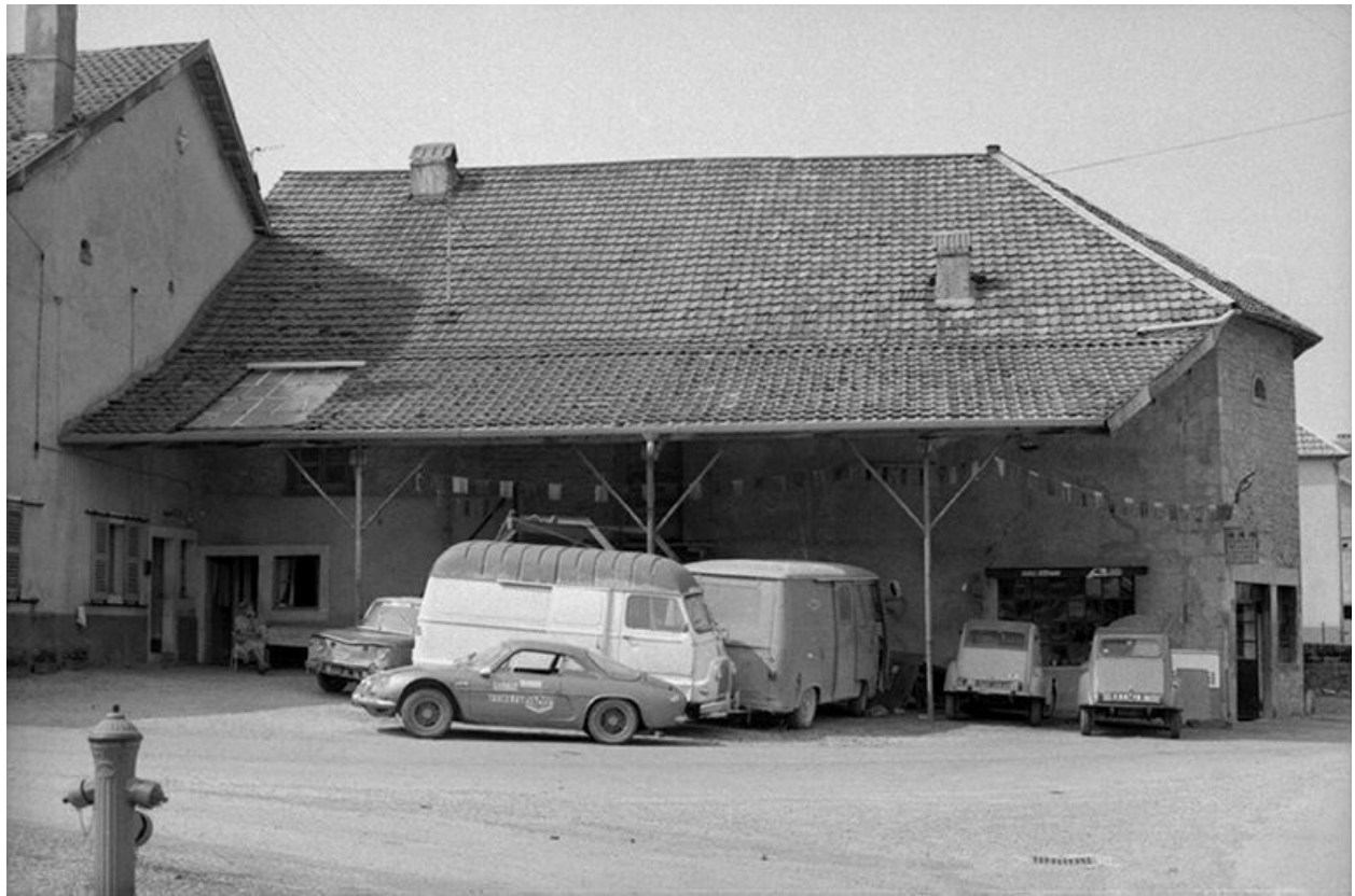
Ferme située 2 rue du Tilleul : façade antérieure.
