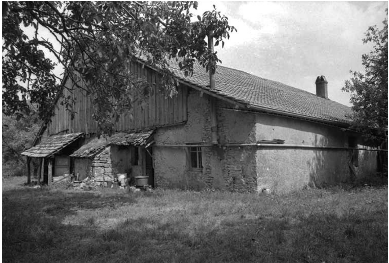
Ferme située au lieudit Chez Barraguet : vue d'ensemble.
