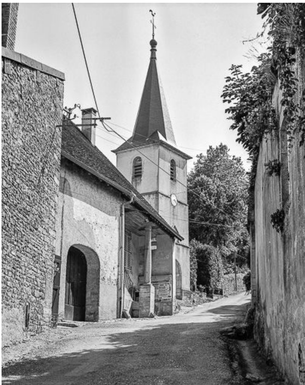
Maison de vigneron située rue de l'Eglise.
