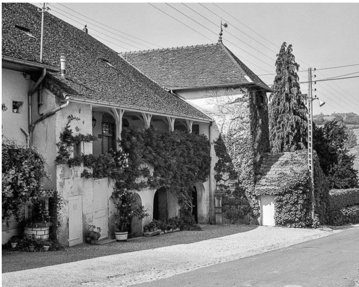
Maison située rue de l'Eglise.
