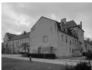
Bâtiment conventuel : élévations postérieure et latérale. Phot. Jean-Luc Duthu IVR26_19922103059V
