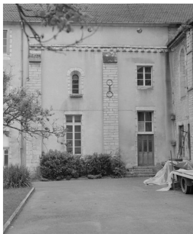
Eglise : bras gauche du transept, élévation antérieure. Phot. Michel Rosso IVR26_19932101269X
