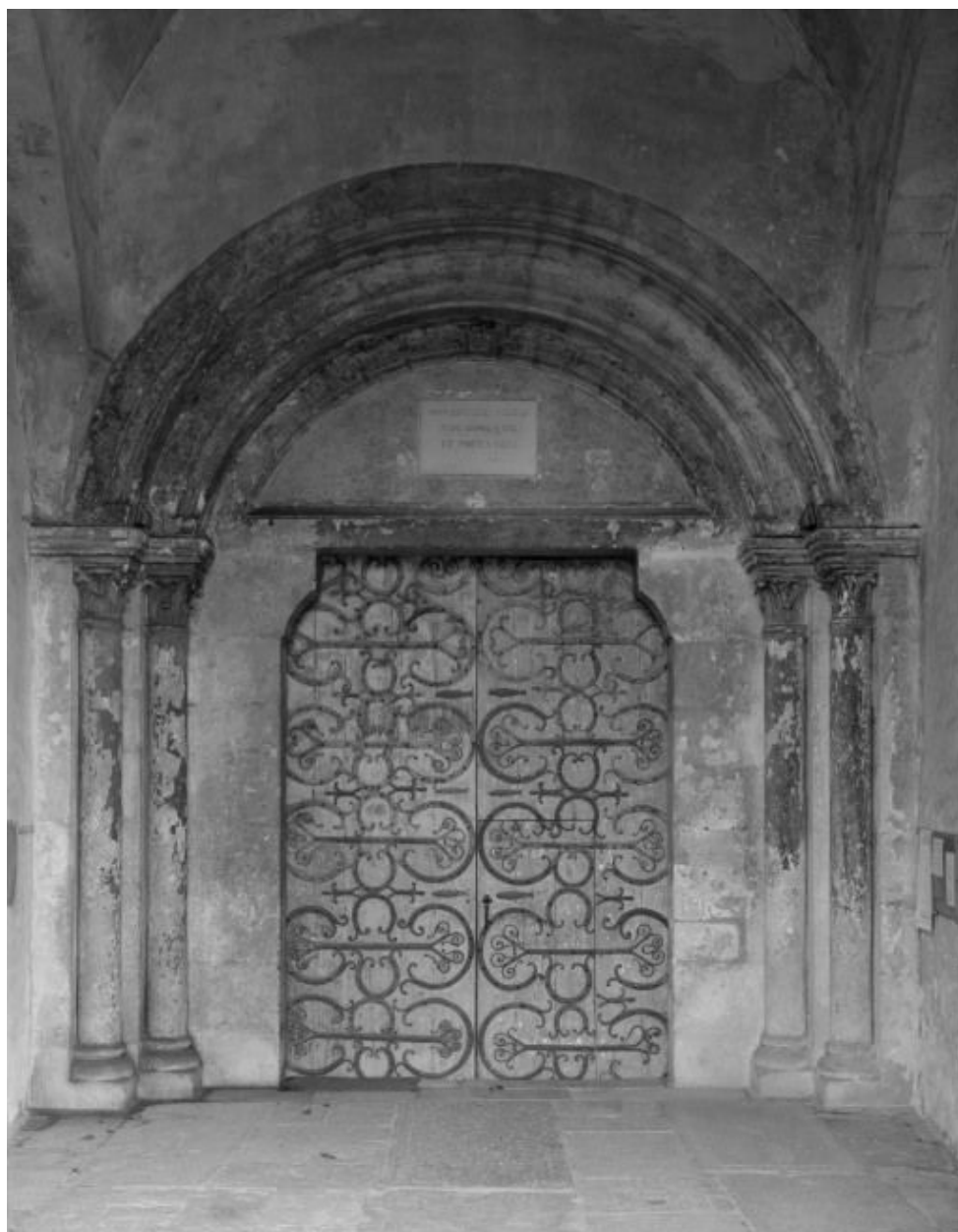
Eglise : porte antérieure de la nef.
