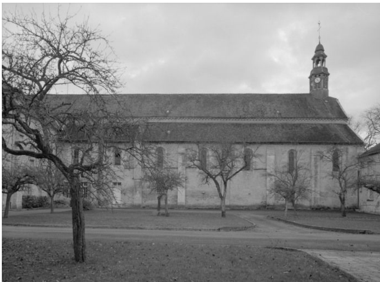
Eglise : élévation gauche.
