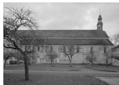
Eglise : élévation gauche. Phot. Jean-Luc Duthu IVR26_19922103055V
