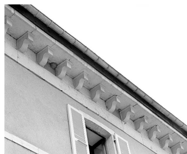
Corniche et corbeaux. Phot. Yves Sancey IVR43_20033900392X
