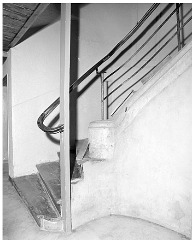
Escalier tournant : première volée. Phot. Yves Sancey IVR43_20033900394X
