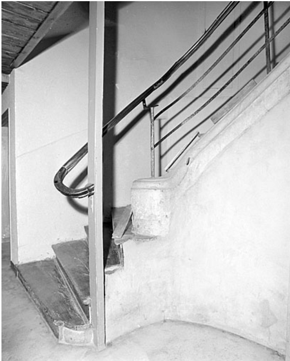
Escalier tournant : première volée.
