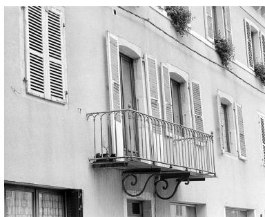
Balcon de la porte-fenêtre centrale. Phot. Yves Sancey IVR43_20033900388X
