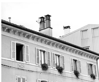
Fenêtres du deuxième étage. Phot. Yves Sancey IVR43_20033900391X
