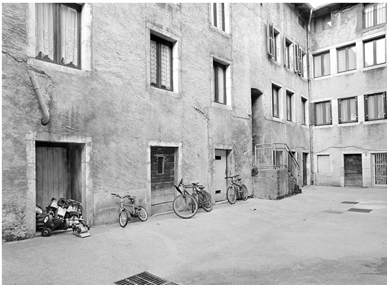
Corps de bâtiment occidental (communs et logements).
