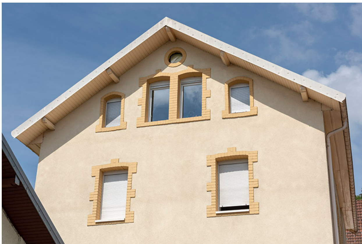
Façade latérale gauche : pignon avec fenêtre horlogère.
