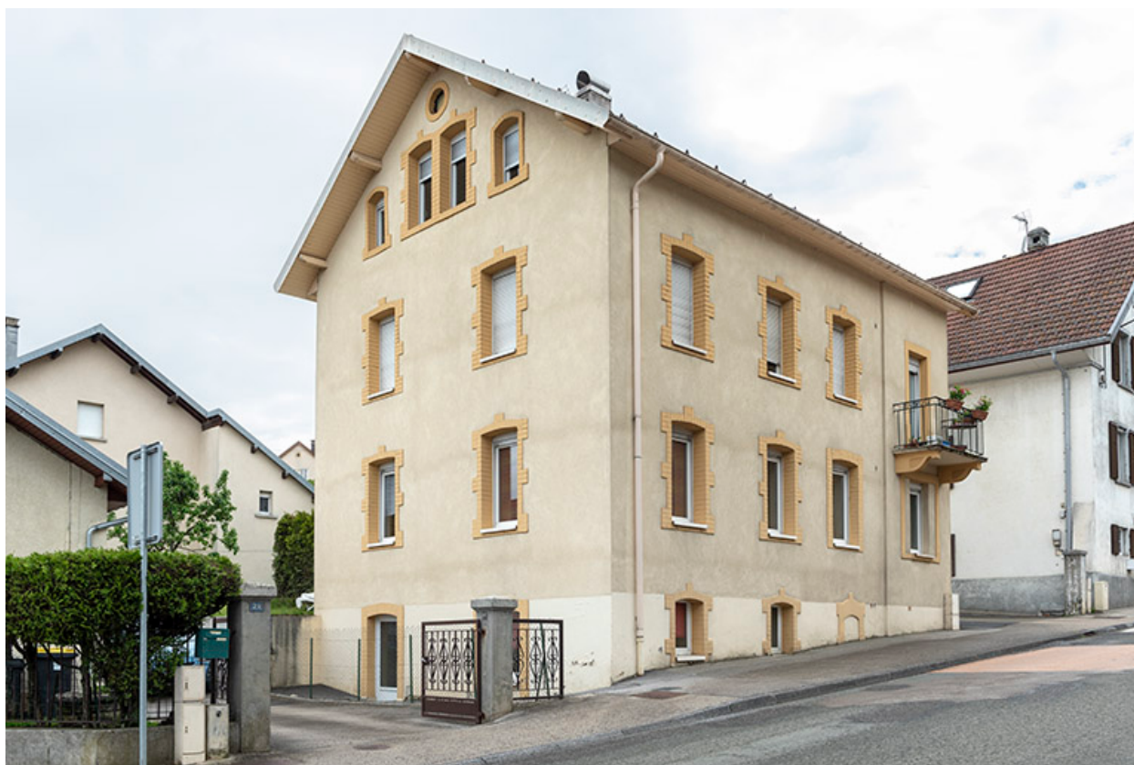
Façades antérieure et latérale gauche.
