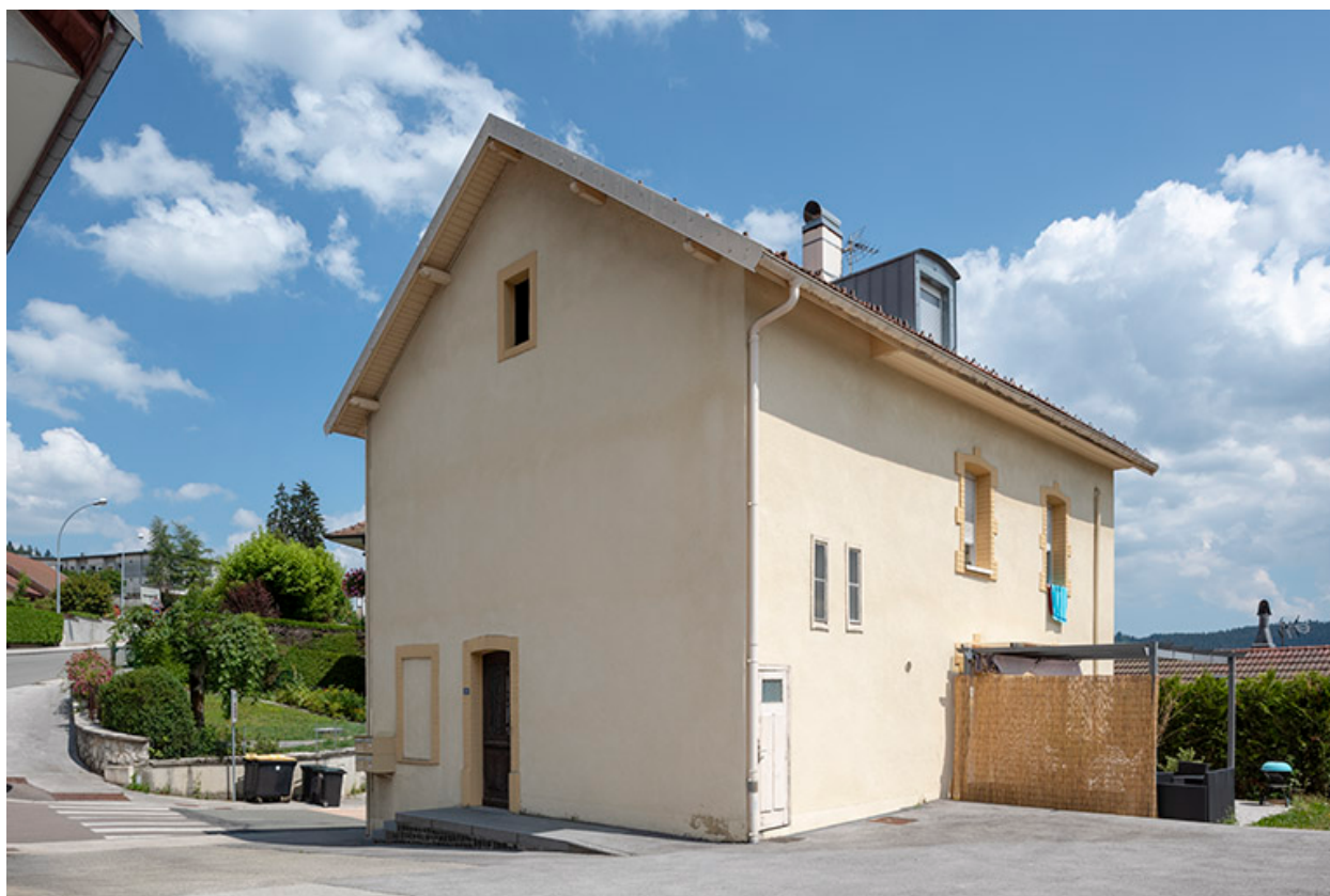
Façades postérieure et latérale droite.
