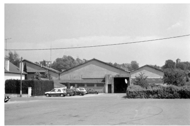
Façade postérieure vue de l'ouest. Phot. Laurent Poupard IVR43_19893900033Z
