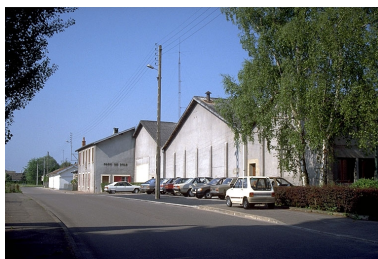
Façade antérieure vue de l'est. Phot. Laurent Poupard IVR43_19893900032ZA
