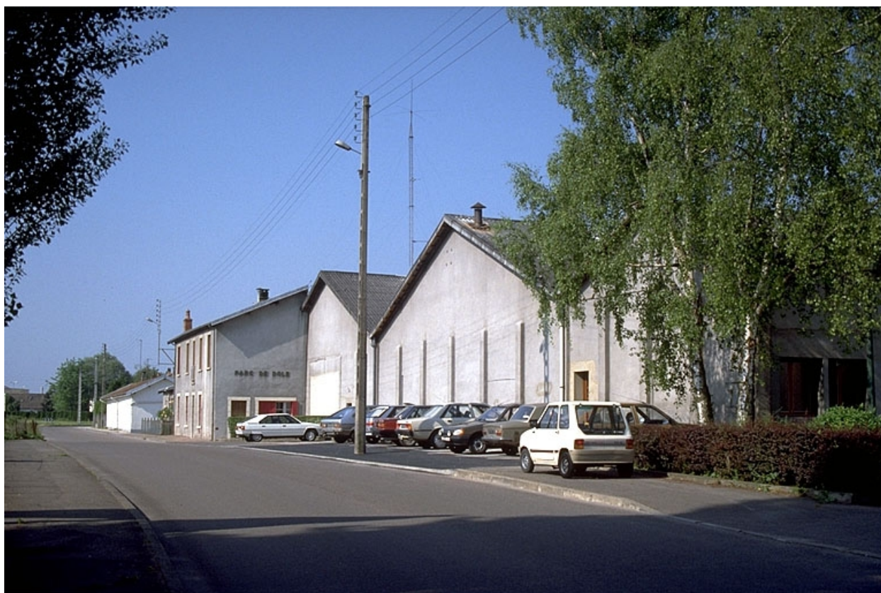
Façade antérieure vue de l'est.
