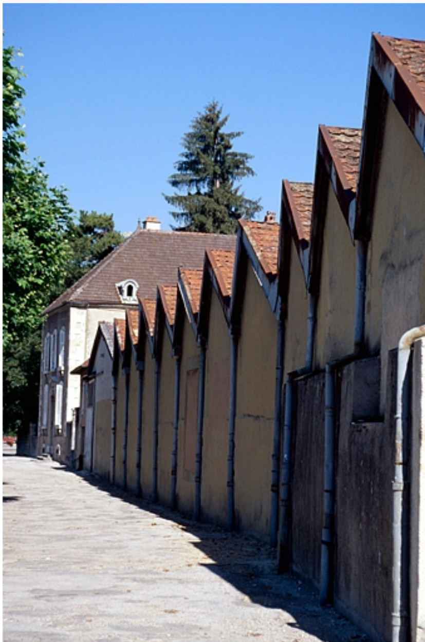
Façades sud et sheds des magasins industriels.
