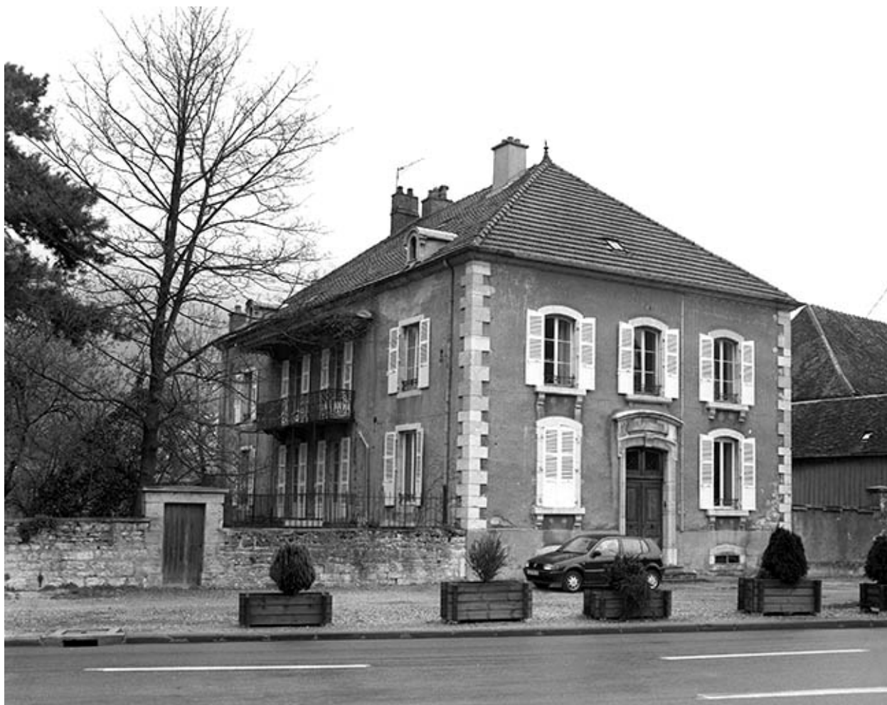
Logement patronal vu de trois quarts.
