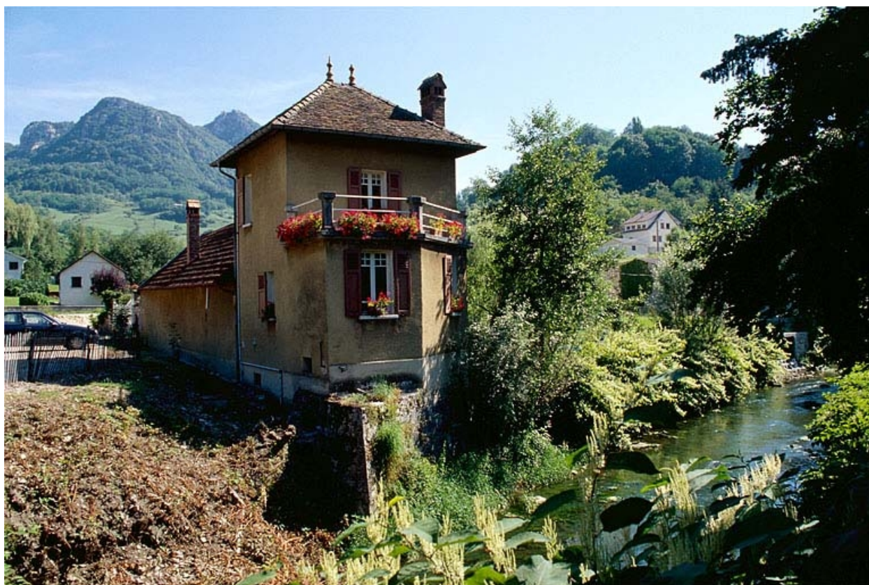
Logement d'employés depuis le sud-est.
