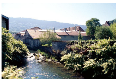
Façades postérieures depuis la Furieuse en aval. Phot. Yves Sancey IVR43_19973901027ZA
