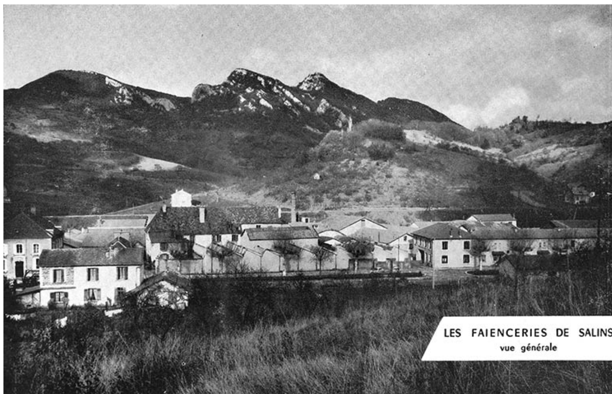
Les Faïenceries de Salins. Vue générale.
