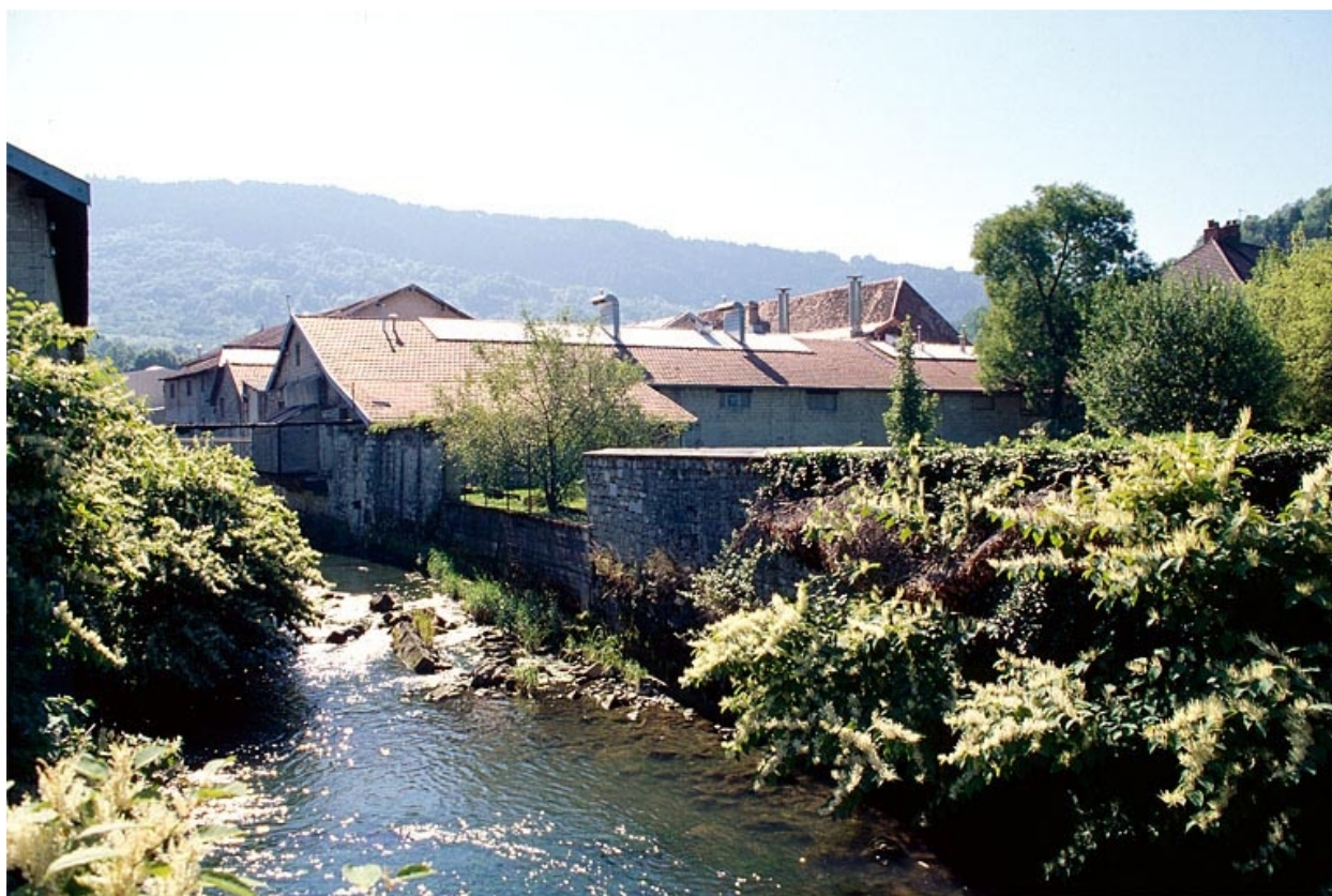
Façades postérieures depuis la Furieuse en aval.
