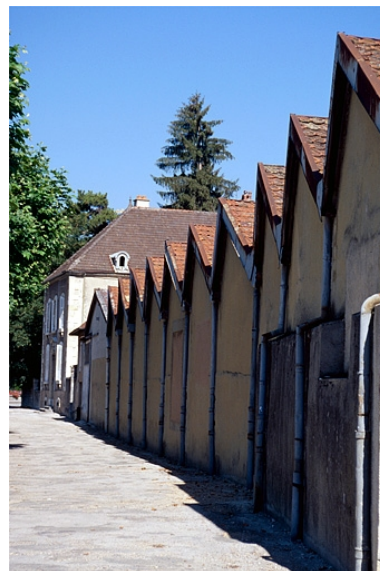
Façades sud et sheds des magasins industriels. Phot. Yves Sancey IVR43_19973901031ZA
