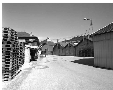
Les ateliers de fabrication depuis la cour. Phot. Yves Sancey IVR43_19973901041X
