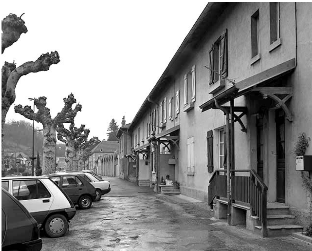
Façade antérieure des logements ouvriers.
