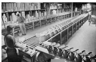
La chaîne de coulage. Phot. Jérôme Mongreville IVR43_19973900291X
