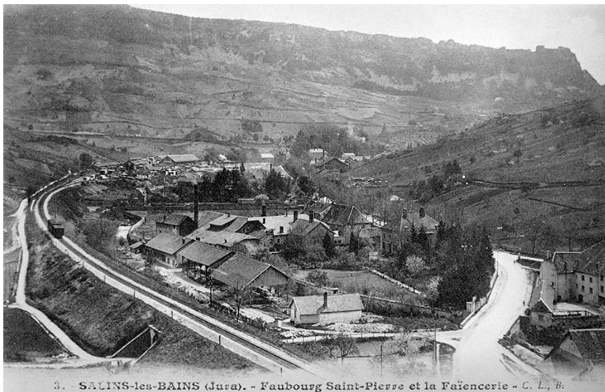
Salins-les-Bains (Jura). - Faubourg Saint-Pierre et la Faïencerie.
