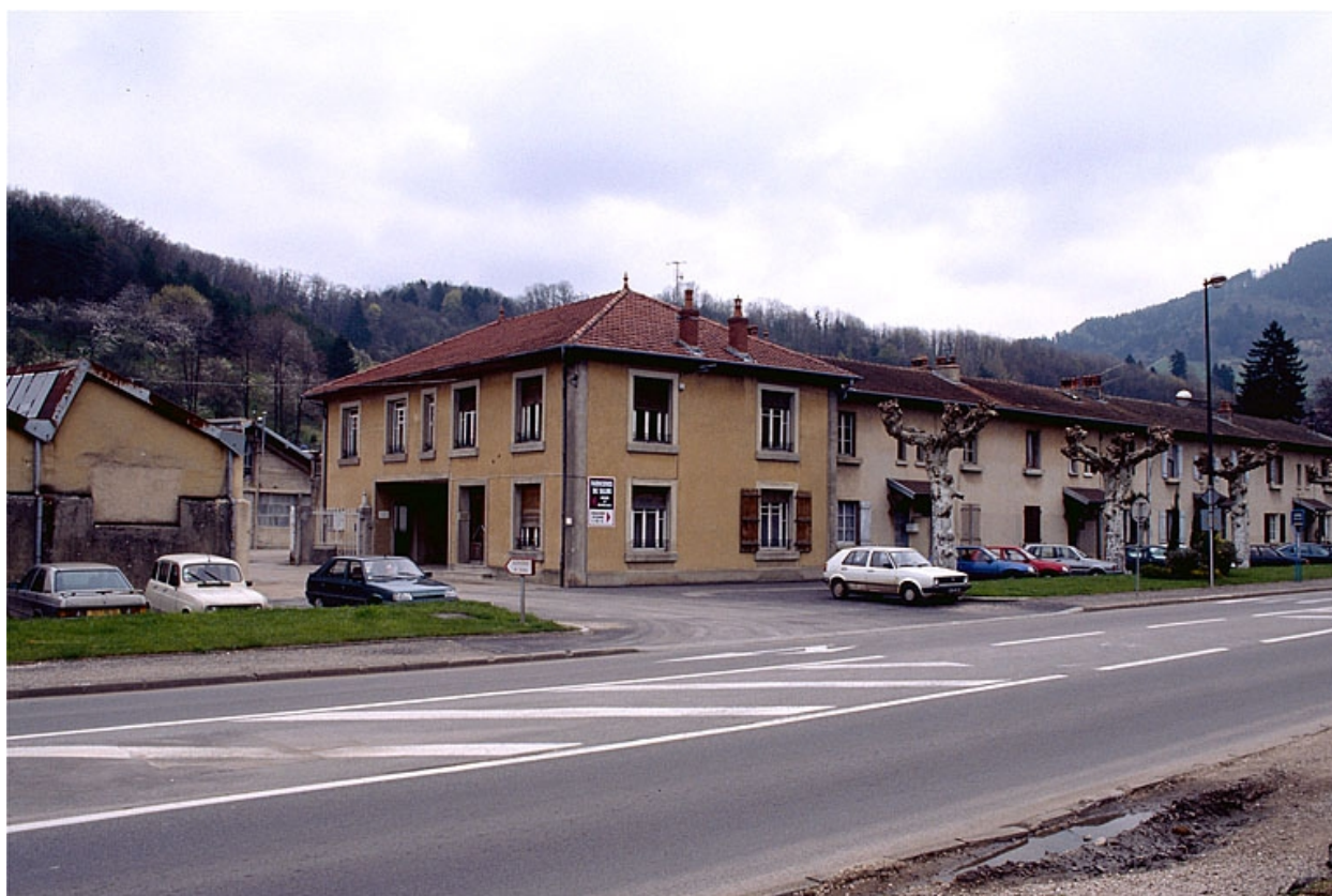
Entrée de l'usine depuis l'avenue.
