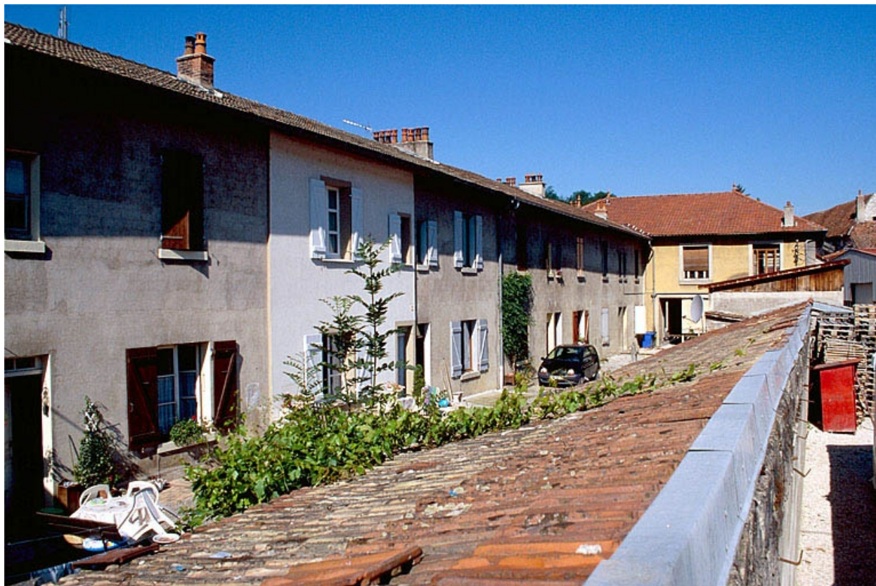
Façade postérieure des logements ouvriers.
