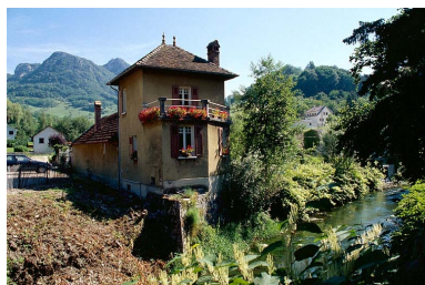
Logement d'employés depuis le sud-est. Phot. Yves Sancey IVR43_19973901045ZA
