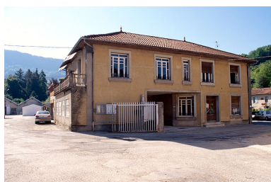
Les bureaux. Phot. Yves Sancey IVR43_19973901034ZA
