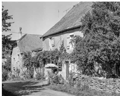
Vue d'ensemble, trois quarts droit. Phot. Dominique Dominguez IVR43_19807000137X
