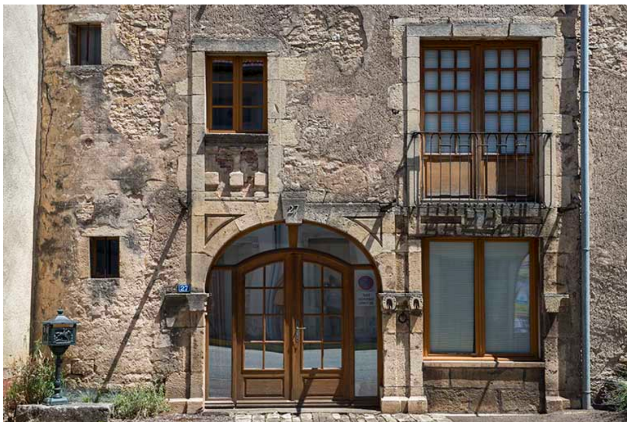
Baies du rez-de-chaussée et du premier étage.
