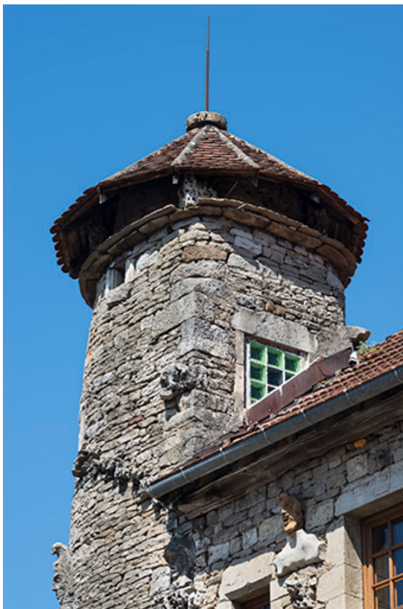
Dernier niveau et couverture de la tourelle.
