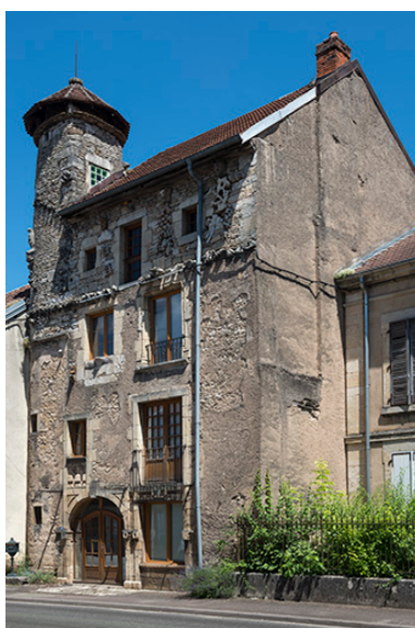
Élévation sur la rue Armand- Paulmard, vue de trois quarts. Phot. Jérôme Mongreville IVR43_20187000429NUC4A
