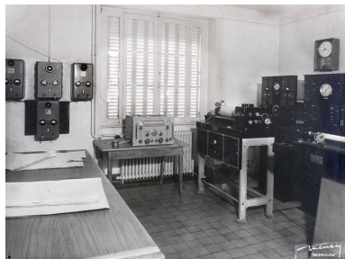
[Chronographes Belin (au premier plan) et horloges à diapason (à l'arrière-plan)], 1948. Autr. Meusy, Phot. Yves Sancey IVR43_20072500641NUCA
