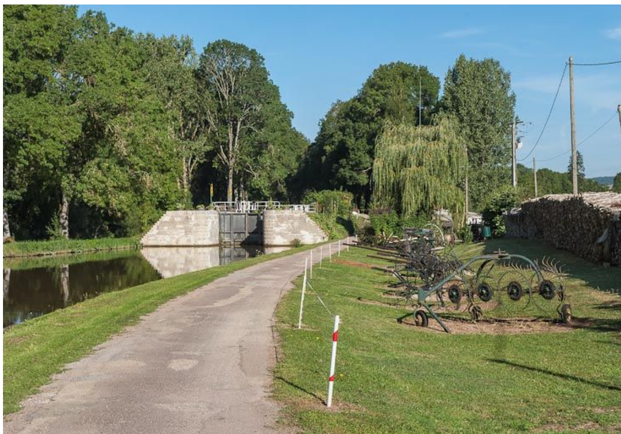
Vue rapprochée de l'écluse depuis l'aval.
