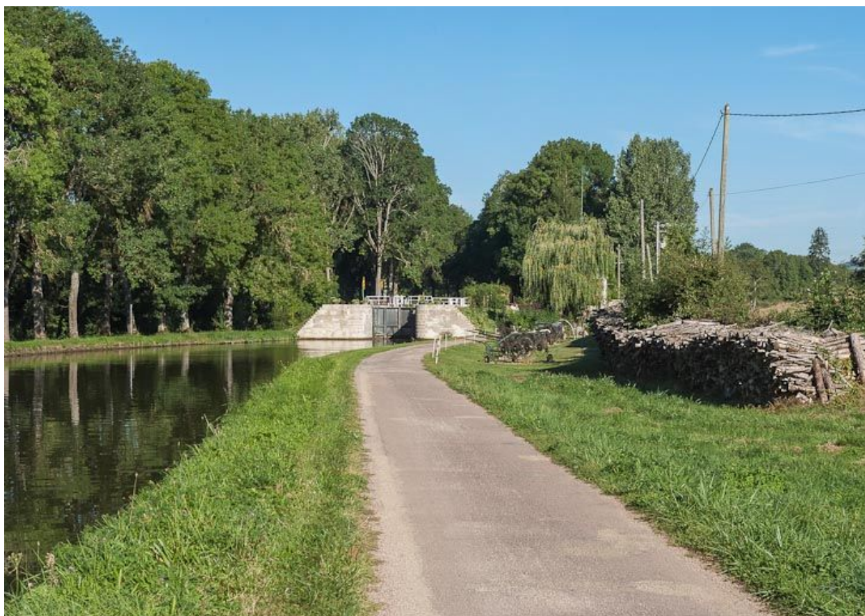
Vue de l'écluse depuis l'aval.
