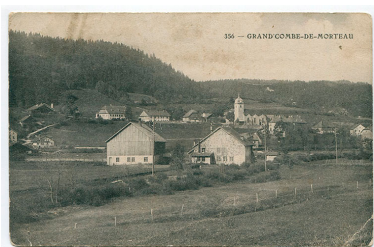
356 - Grand'Combe-de-Morteau, 1er quart 20e siècle [avant 1909]. Autr. auteur inconnu IVR43_20172501535NUC4A
