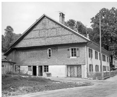
Façade latérale gauche de trois quarts droite, en 1976. Phot. Dominique Humbert IVR43_19762500720X
