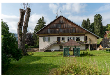
Façade latérale droite. Phot. Sonia Dourlot IVR43_20172501052NUC4A
