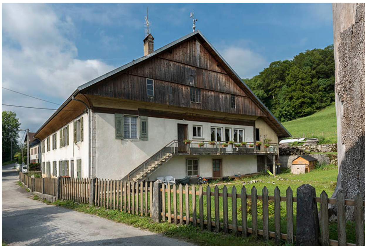
Façade latérale droite, de trois quarts gauche.
