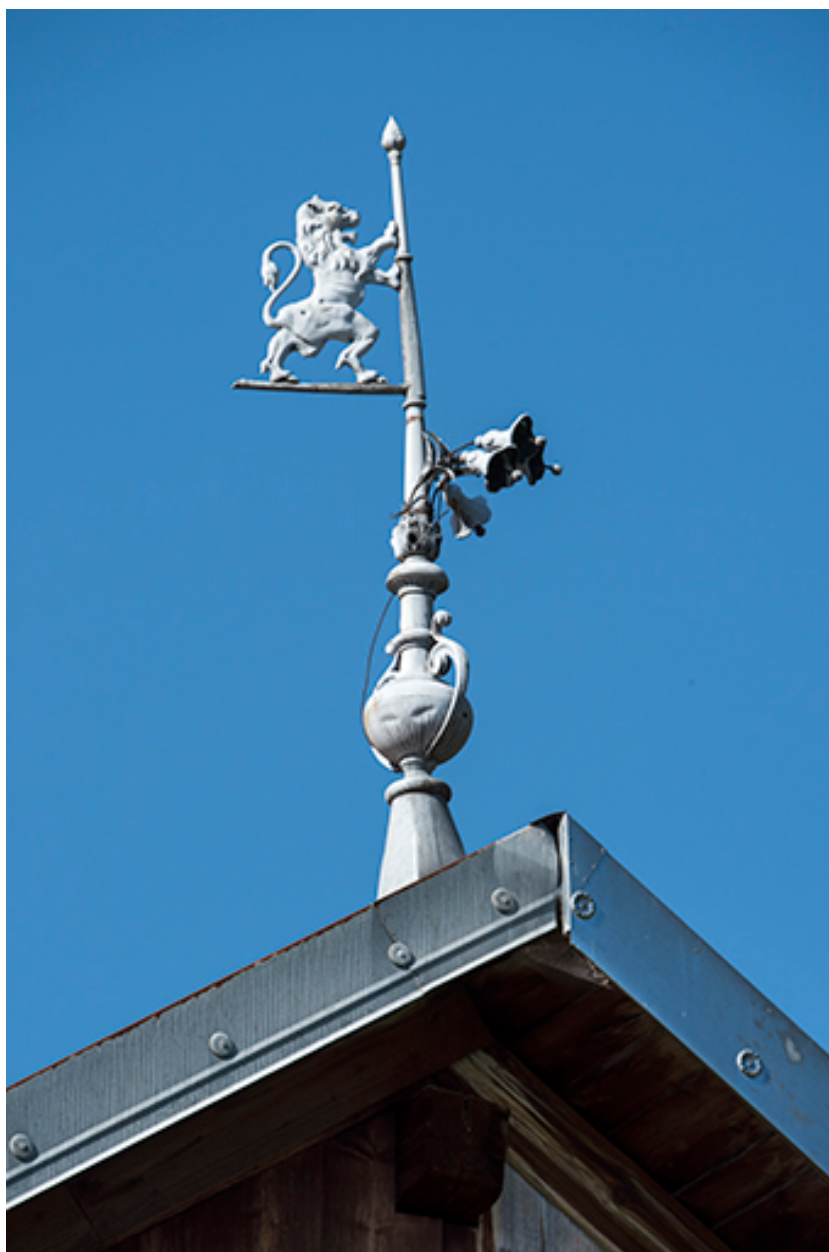
Façade latérale droite : épi de faîtage.
