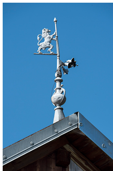
Façade latérale droite : épi de faîtage. Phot. Sonia Dourlot IVR43_20172501054NUC4A
