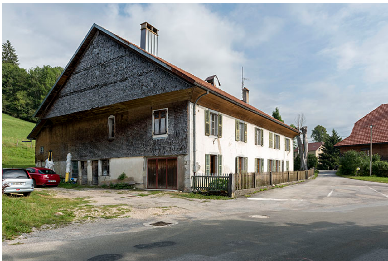
Façades antérieure et latérale gauche.
