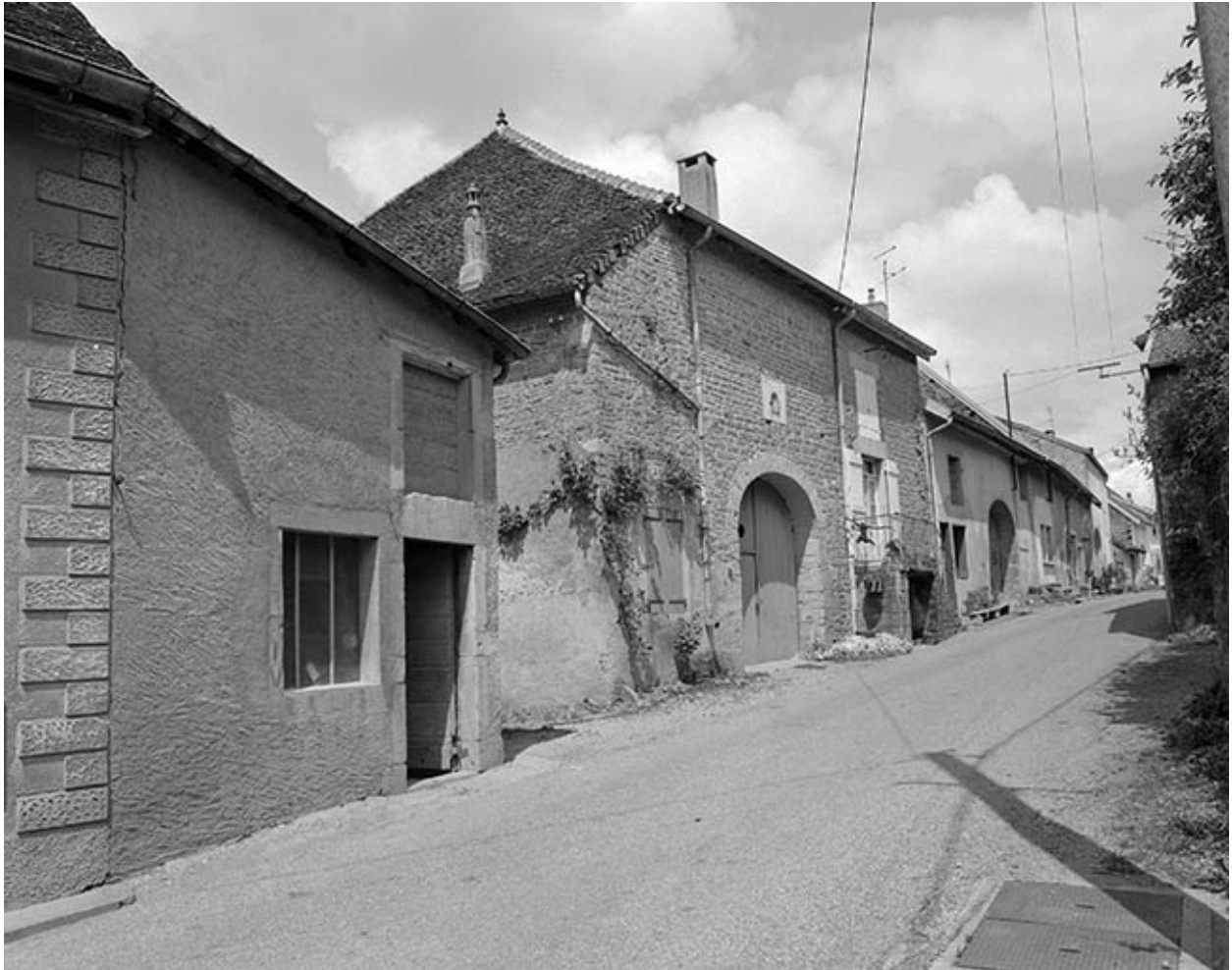
Façade antérieure, vue de trois quarts gauche.
