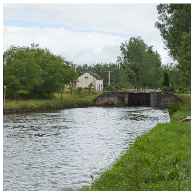
Site d'écluse vu depuis l'aval. Phot. Pierre-Marie Barbe-Richaud IVR26_20112103497NUC2AQ
