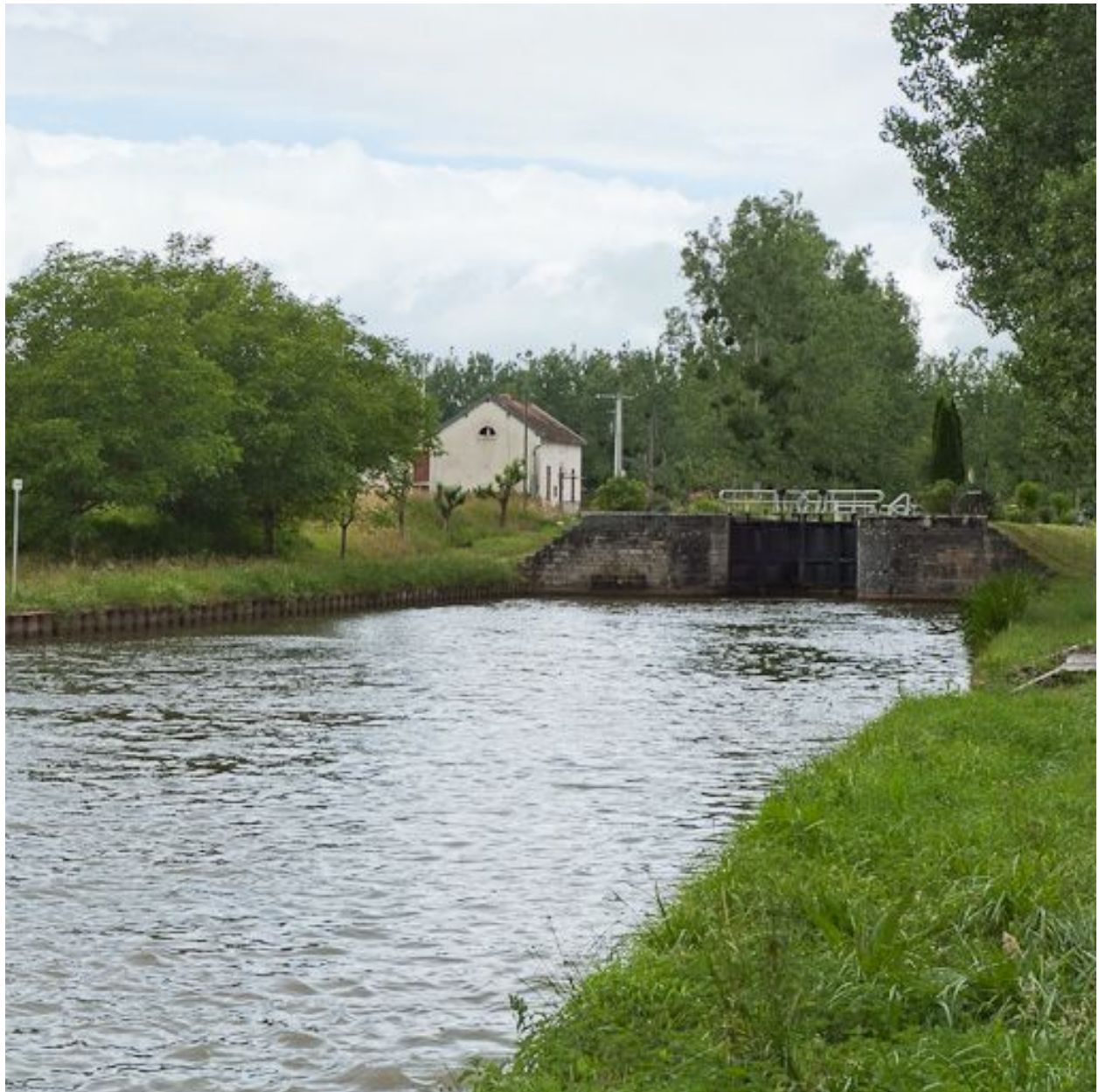
Site d'écluse vu depuis l'aval.
