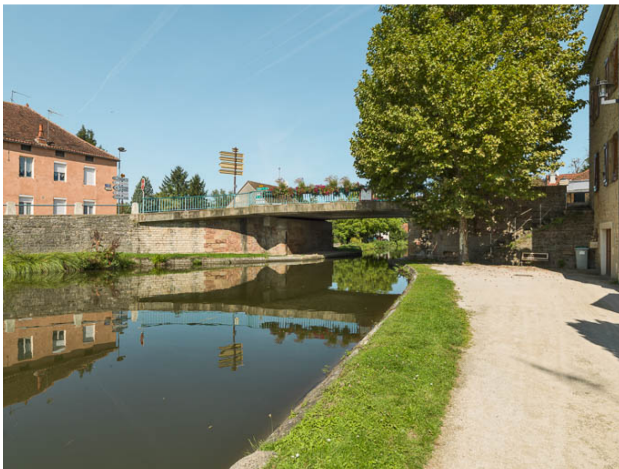
Vue d'ensemble du pont.
