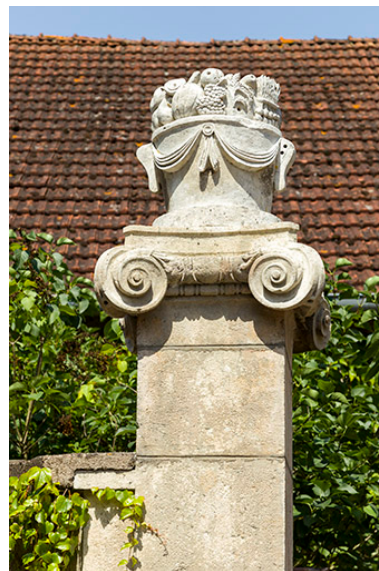
Détail d'un pilier sculpté de l'entrée. Phot. Sonia Dourlot IVR43_20167001800NUC2A
