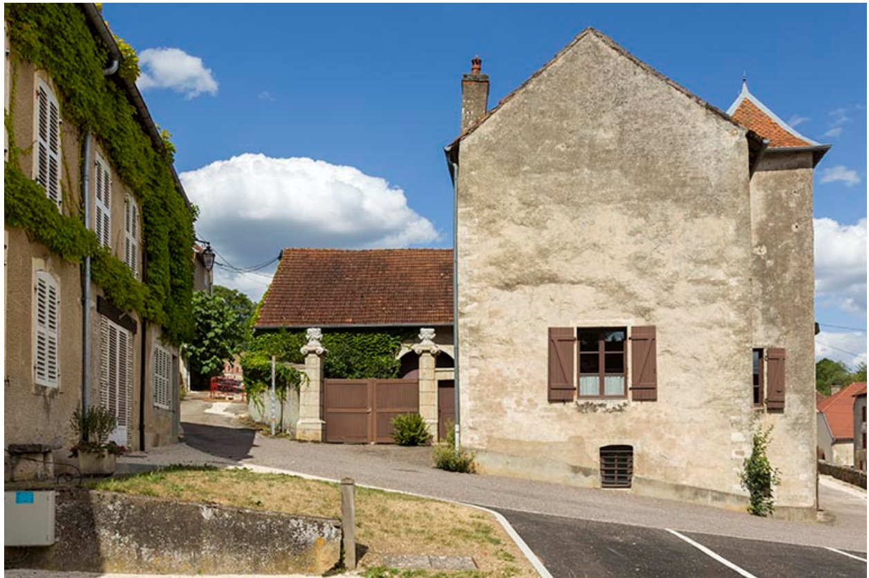
Vue générale depuis la place de l'Abondance.
