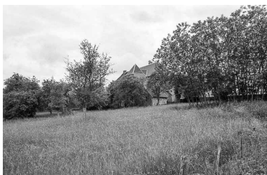
Façade postérieure des bâtiments. Phot. Bernard Lardière IVR43_19817000283Z
