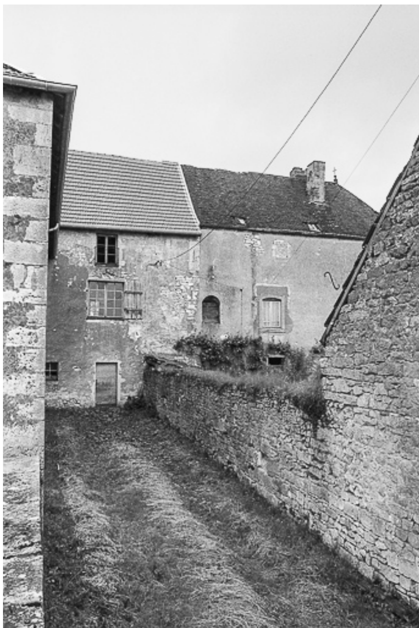
Vue des bâtiments à droite de l'église.
