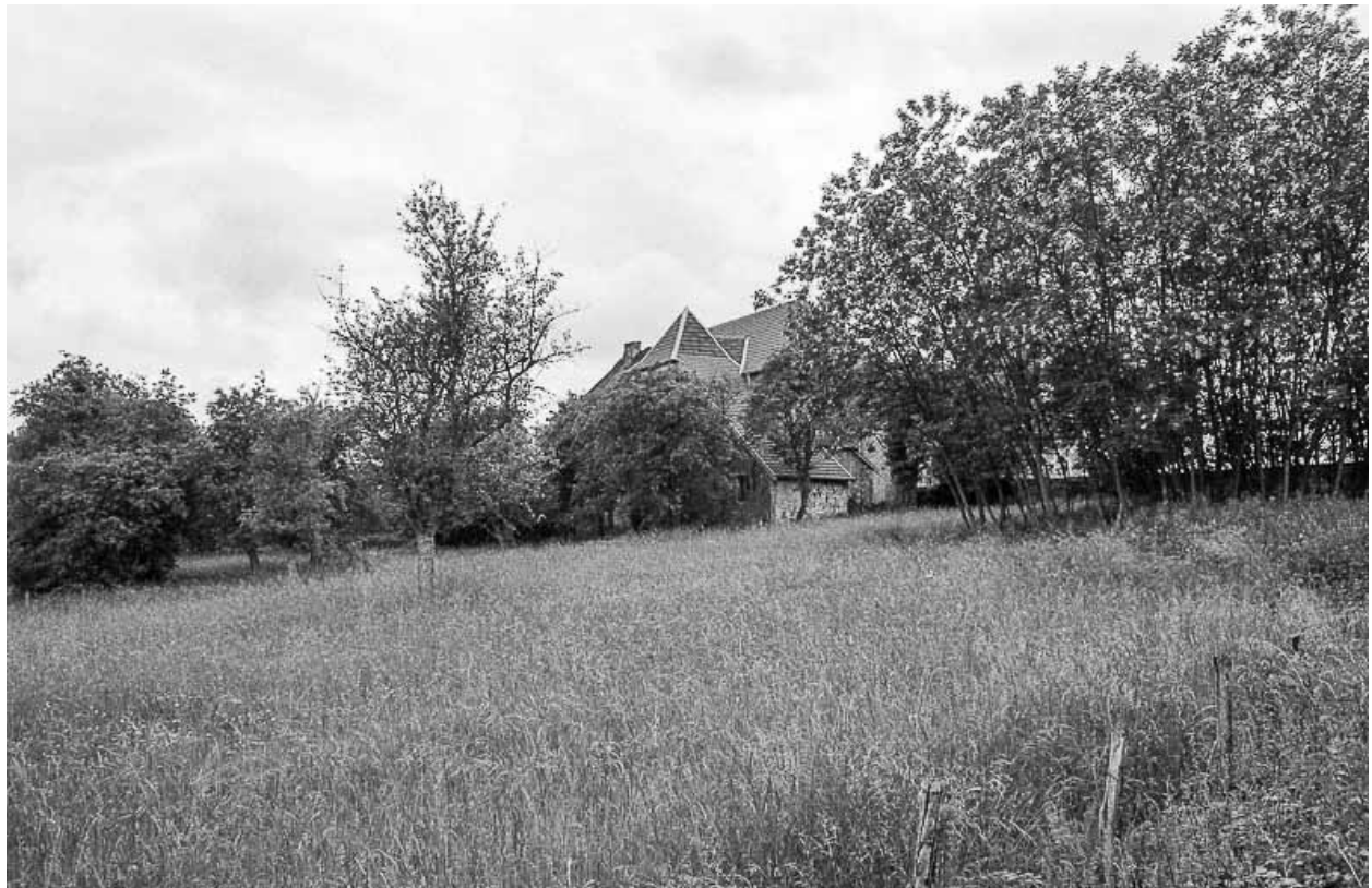
Façade postérieure des bâtiments.
