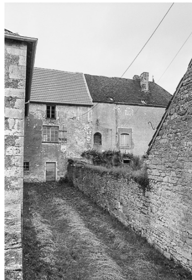
Vue des bâtiments à droite de l'église. Phot. Bernard Lardière IVR43_19817000286Z
