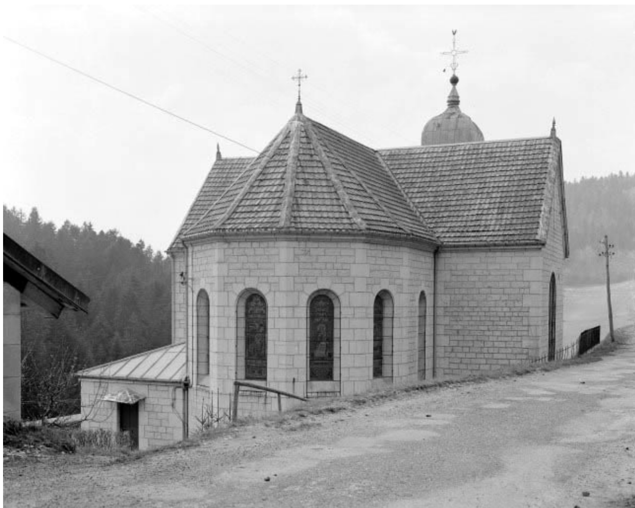
Extérieur : façade postérieure.
