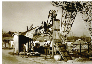
Vue de trois quarts droite. Phot. Yves Sancey IVR43_19943901315ZA
