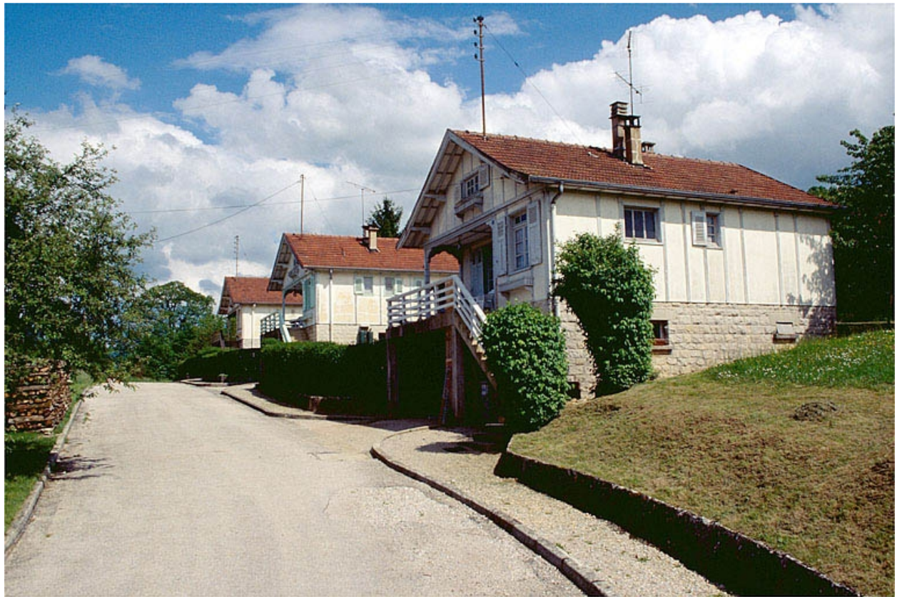
Logements d'ouvriers depuis l'ouest.
