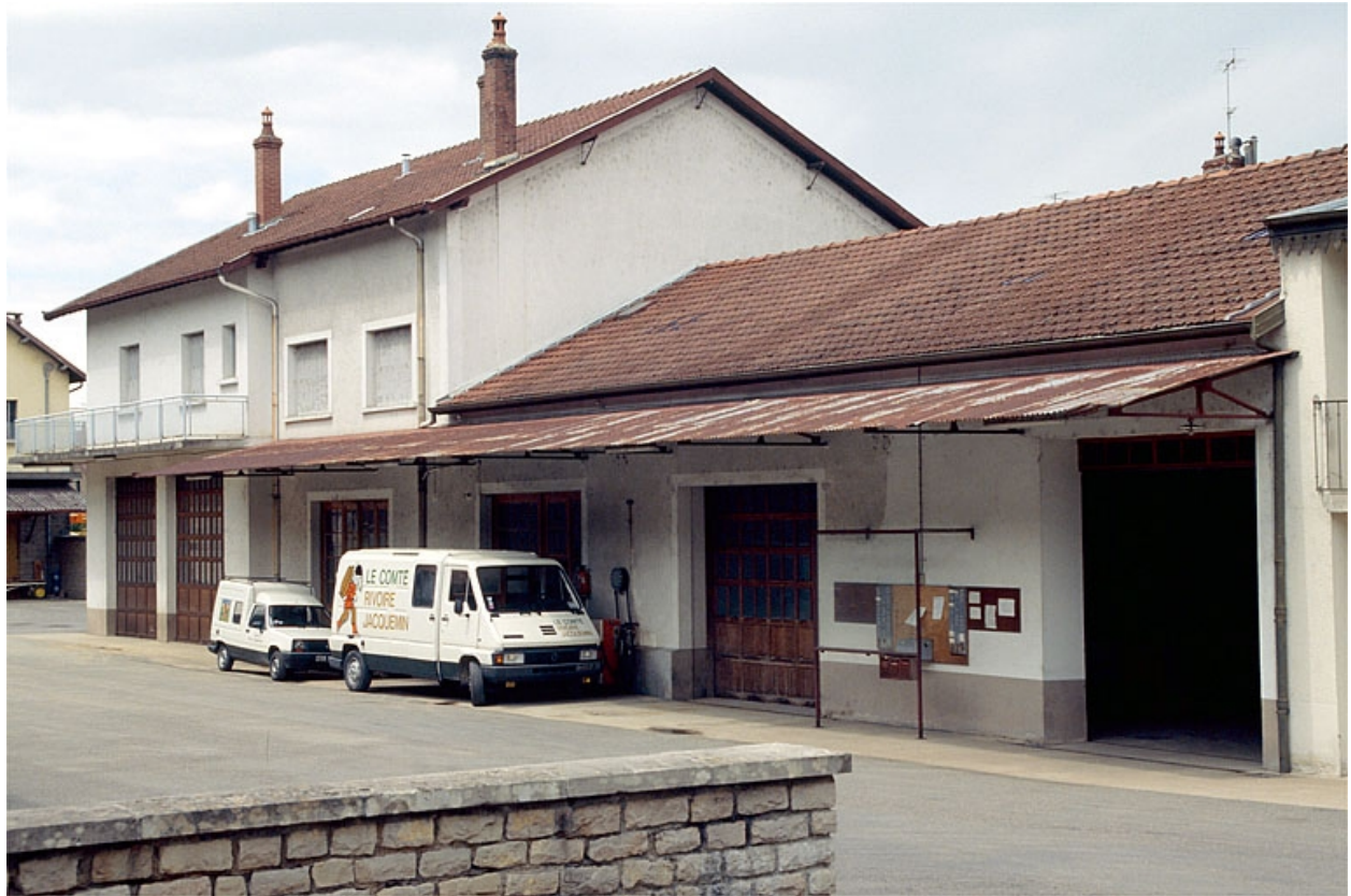
Atelier de réparation, logement et remise.
