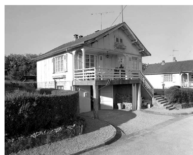
Logement d'ouvriers vu de trois quarts gauche. Phot. Jérôme Mongreville IVR43_19963900531X
