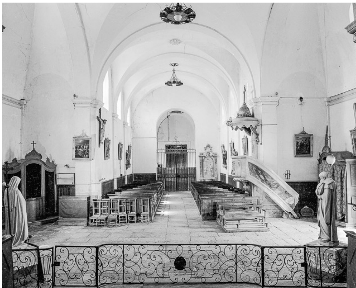
Vue de la nef depuis le chœur.
