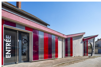
Façade latérale gauche : entrée et vestibule. Phot. Jérôme Mongreville IVR43_20223900350NUC4A
