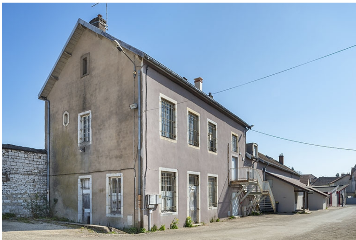
Façade latérale gauche, de trois quarts gauche.
