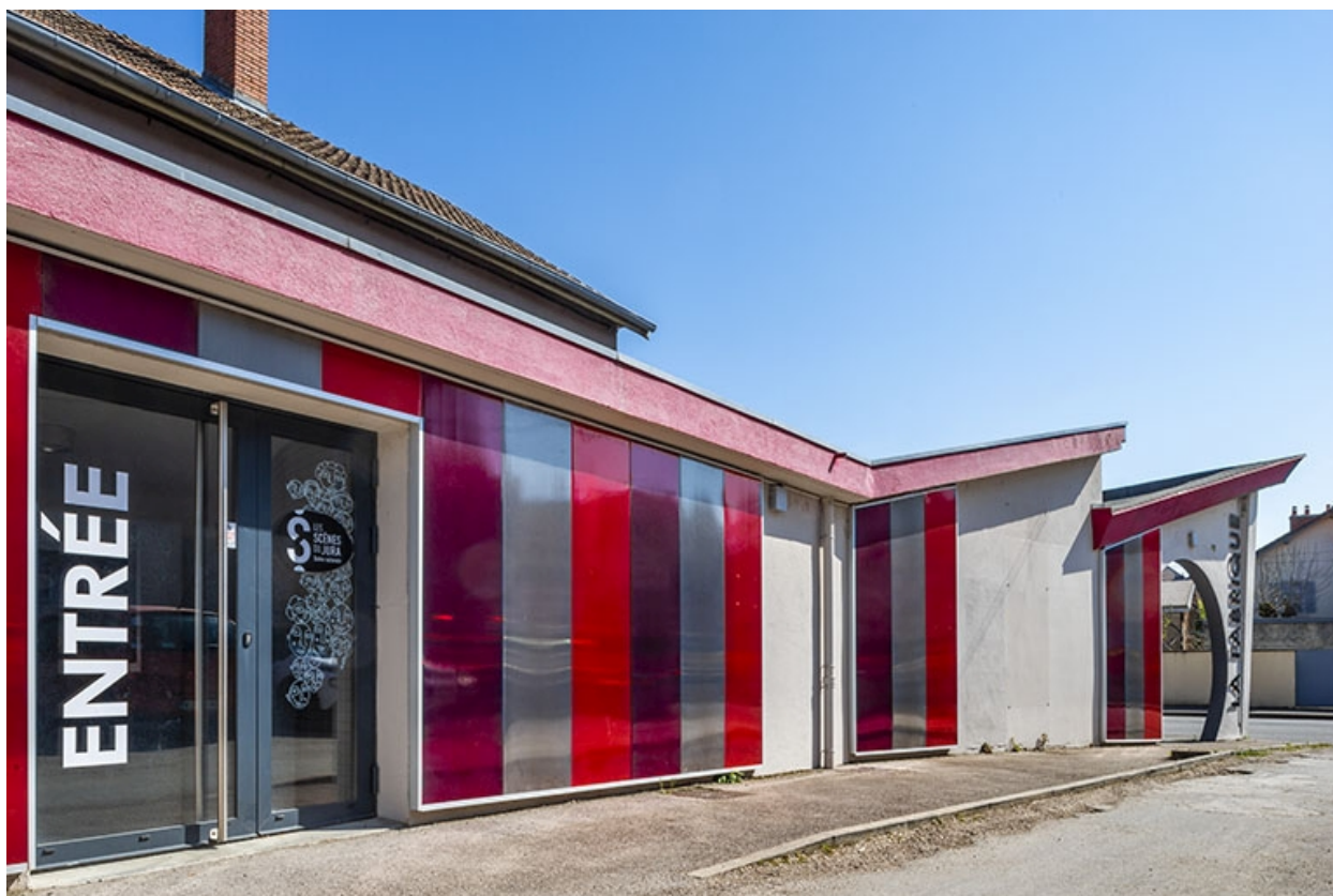
Façade latérale gauche : entrée et vestibule.
