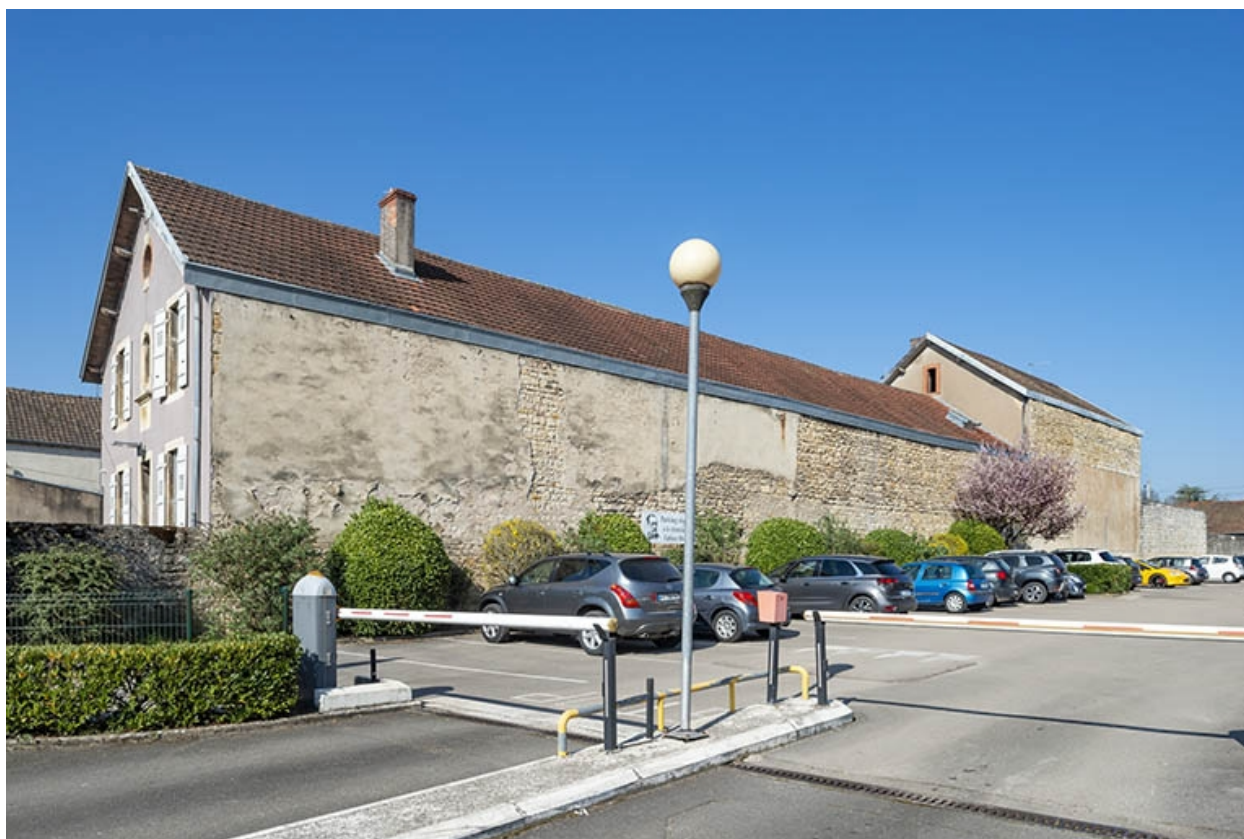
Façade latérale droite.
