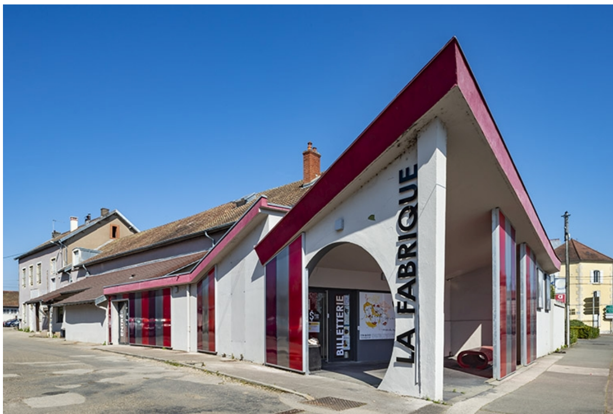
Façade latérale gauche, de trois quarts droite.
