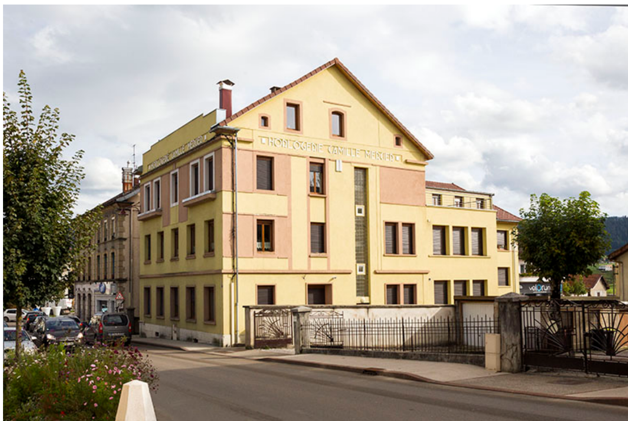
Vue d'ensemble, depuis l'ouest (immeuble et extension).
