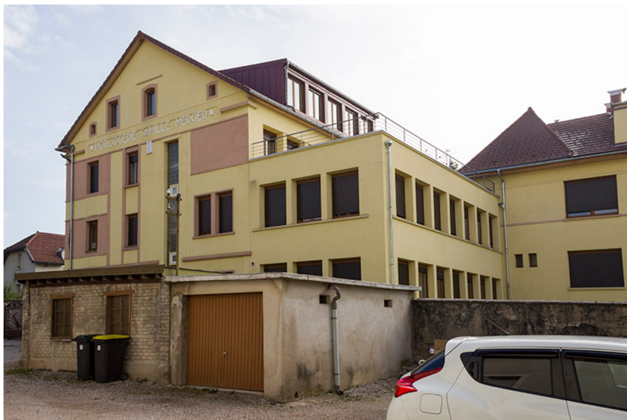
Immeuble et extension, depuis le sud-ouest.
