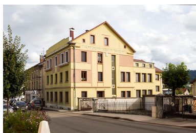
Vue d'ensemble, depuis l'ouest (immeuble et extension).
