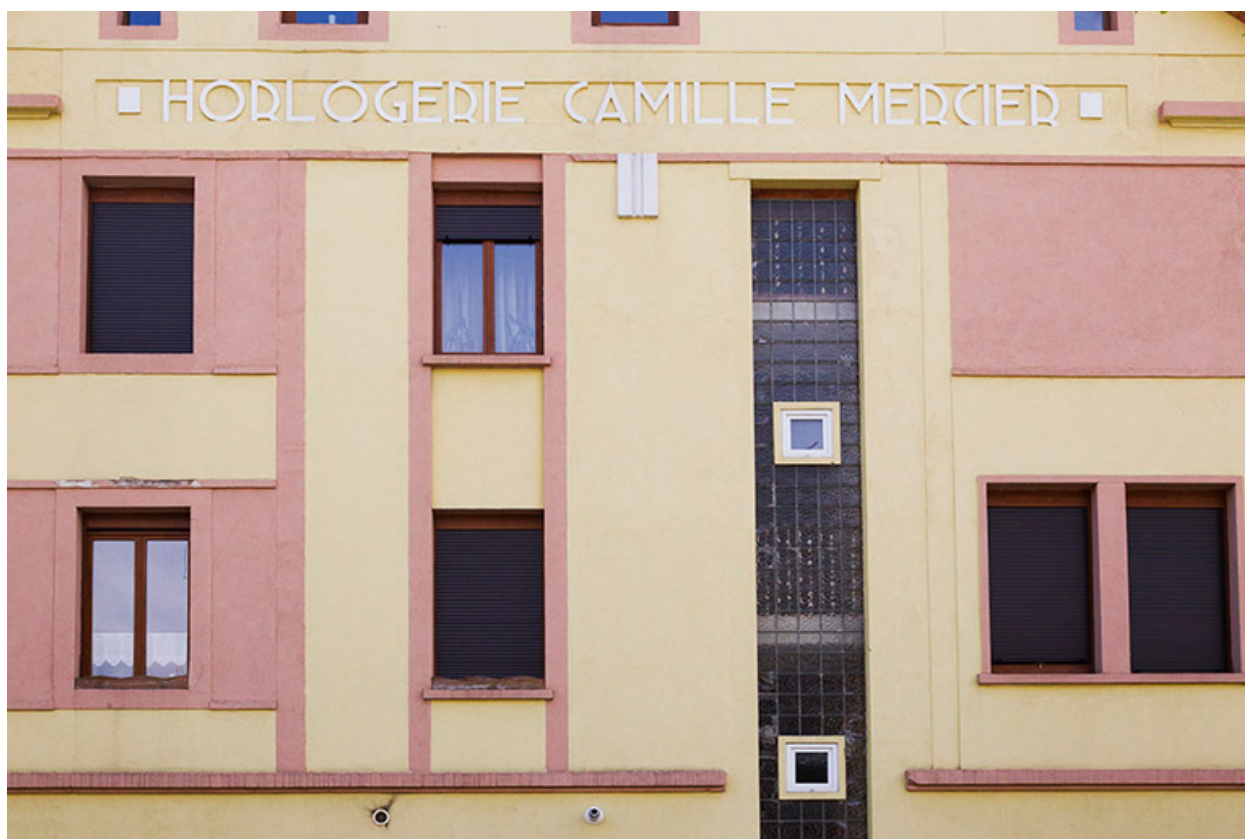
Immeuble : façade latérale droite (étages).
