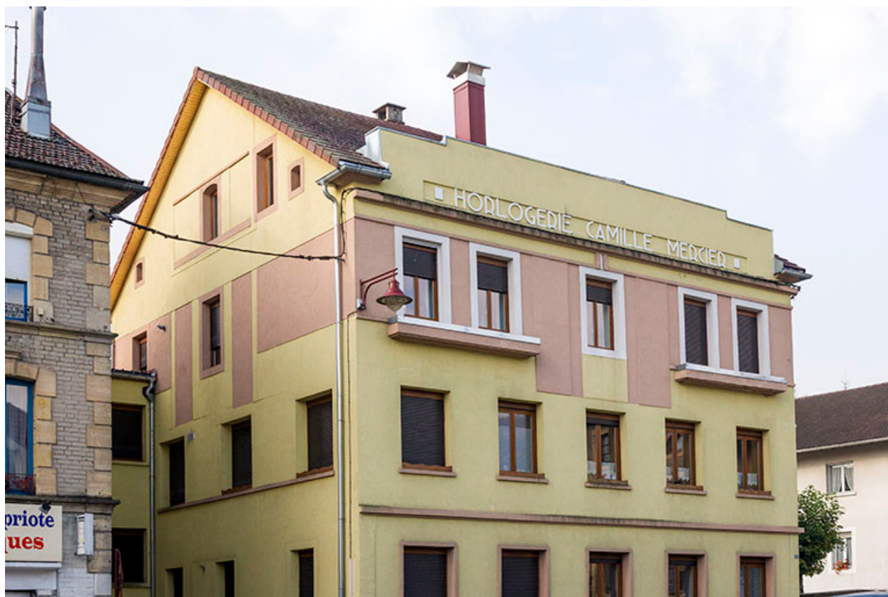
Immeuble : façades antérieure et latérale gauche.
