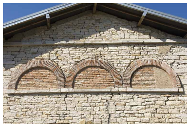
Logement (?) nord. Détail d'arcatures sur le pignon. Phot. Jérôme Mongreville IVR43_20087000811NUC2A
