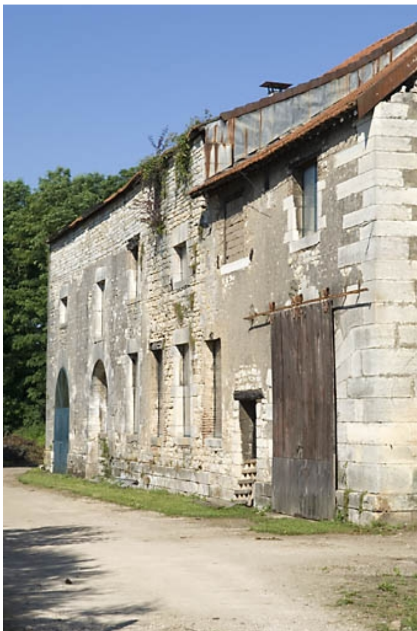
Bâtiment du haut fourneau ouest.
