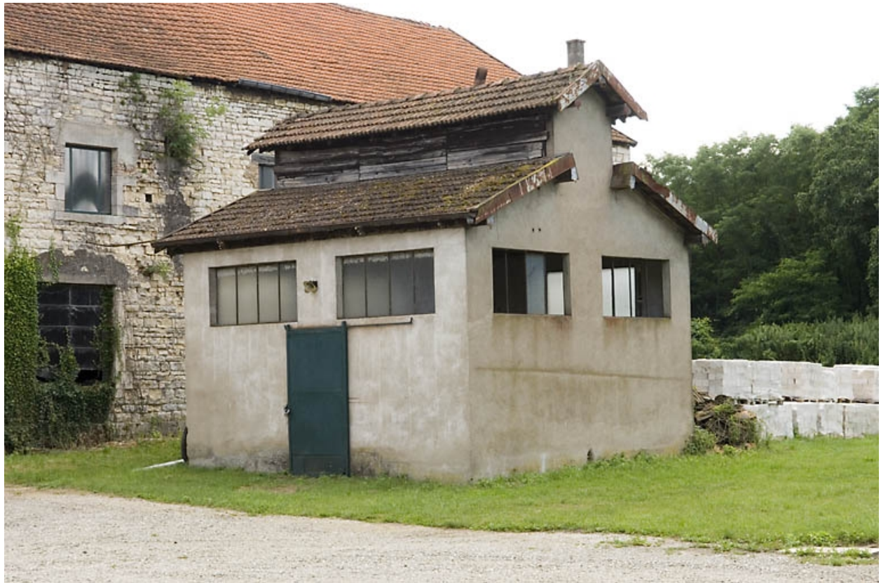
Bâtiment à usage indéterminé.
