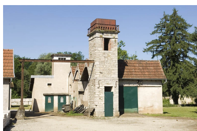
Transformateur, magasin et réservoir industriel (?). Phot. Jérôme Mongreville IVR43_20087000812NUC2A
