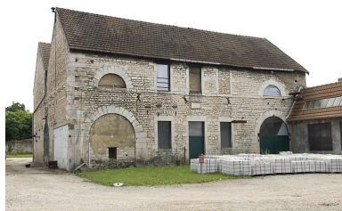
Bâtiment du haut fourneau est. Phot. Jérôme Mongreville IVR43_20087000857NUC2A
