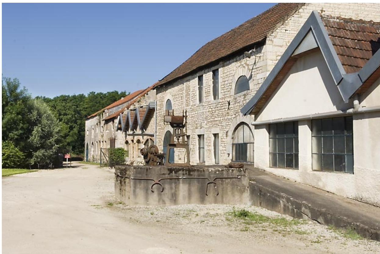
Façades sud des divers ateliers de métallurgie.
