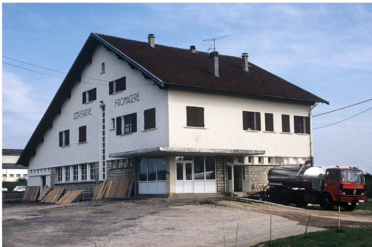
Façades antérieure et latérale gauche.
