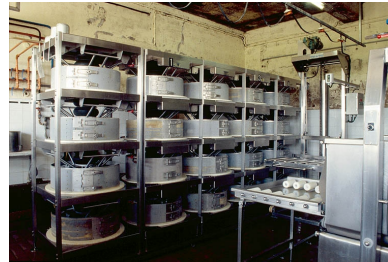
Presse hydraulique. Phot. Jérôme Mongreville IVR43_19953900251ZA
