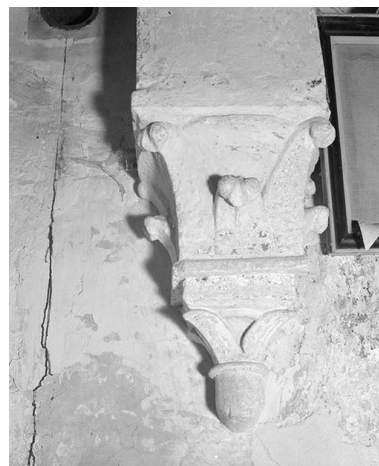
Chapiteau à crochets prolongé par un second chapiteau plus petit, orné de feuilles lisses, sur lequel repose le doubleau du chœur. Phot. Michel Thierry IVR26_19748900301X
