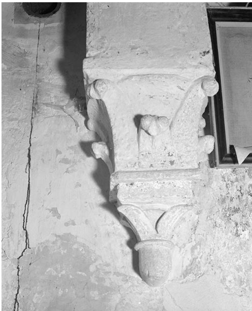
Chapiteau à crochets prolongé par un second chapiteau plus petit, orné de feuilles lisses, sur lequel repose le doubleau du chœur.
