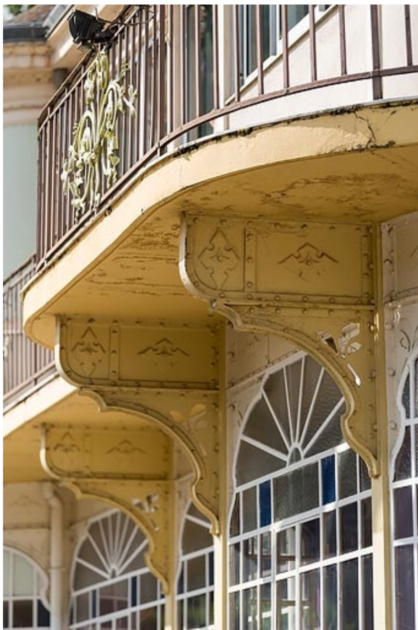
Aile ouest, salle à manger, détail.
