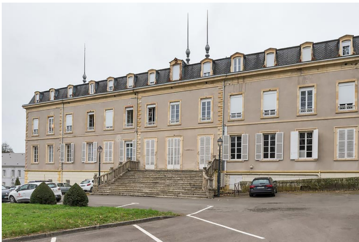
Aile nord, façade.
