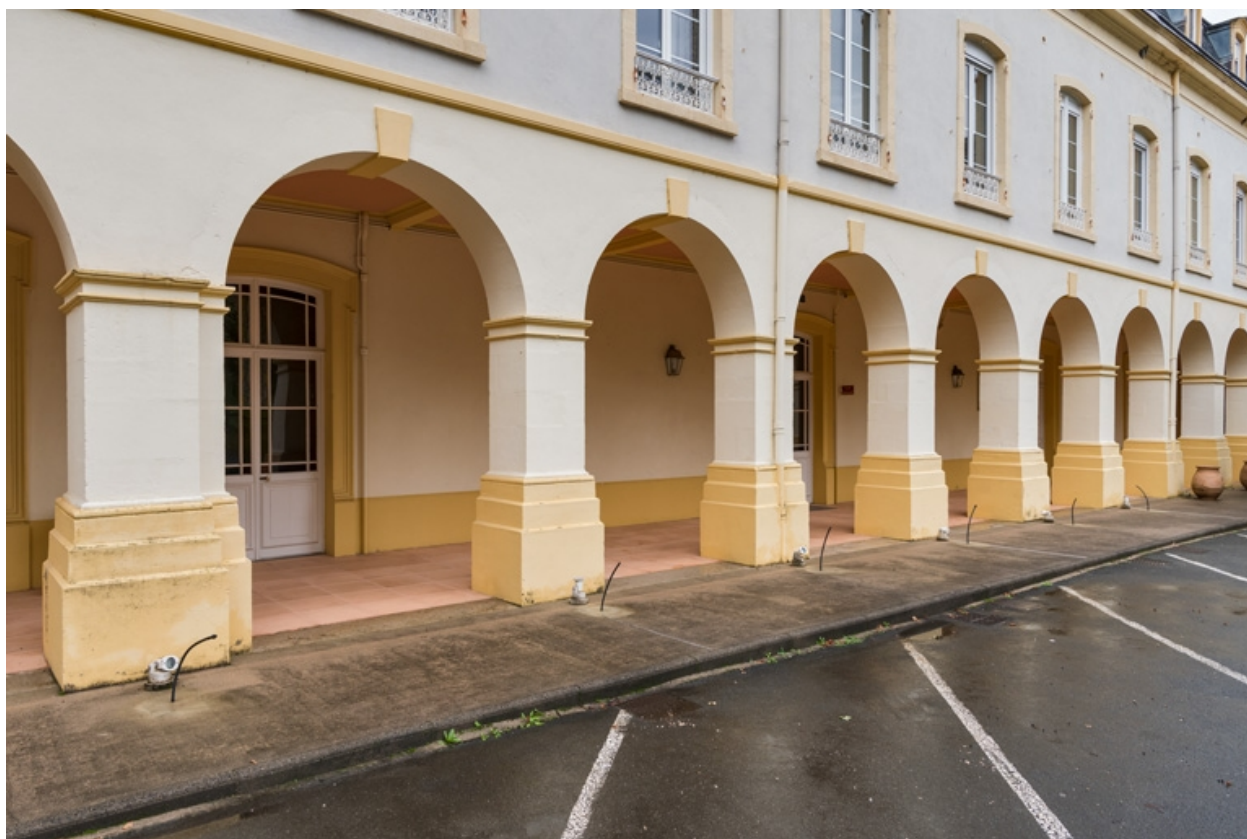
Cour, détail de l'aile nord.
