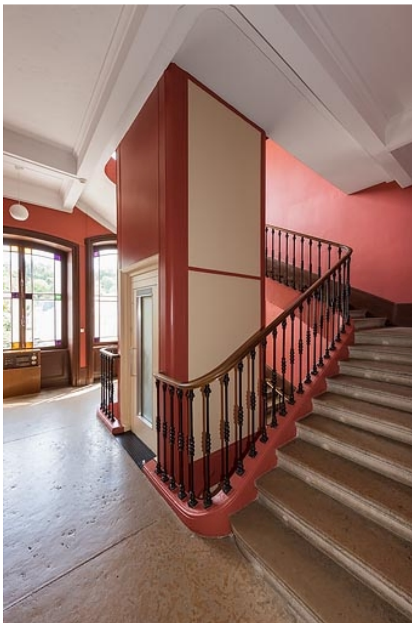
Vue intérieure de la cage d'escalier.
