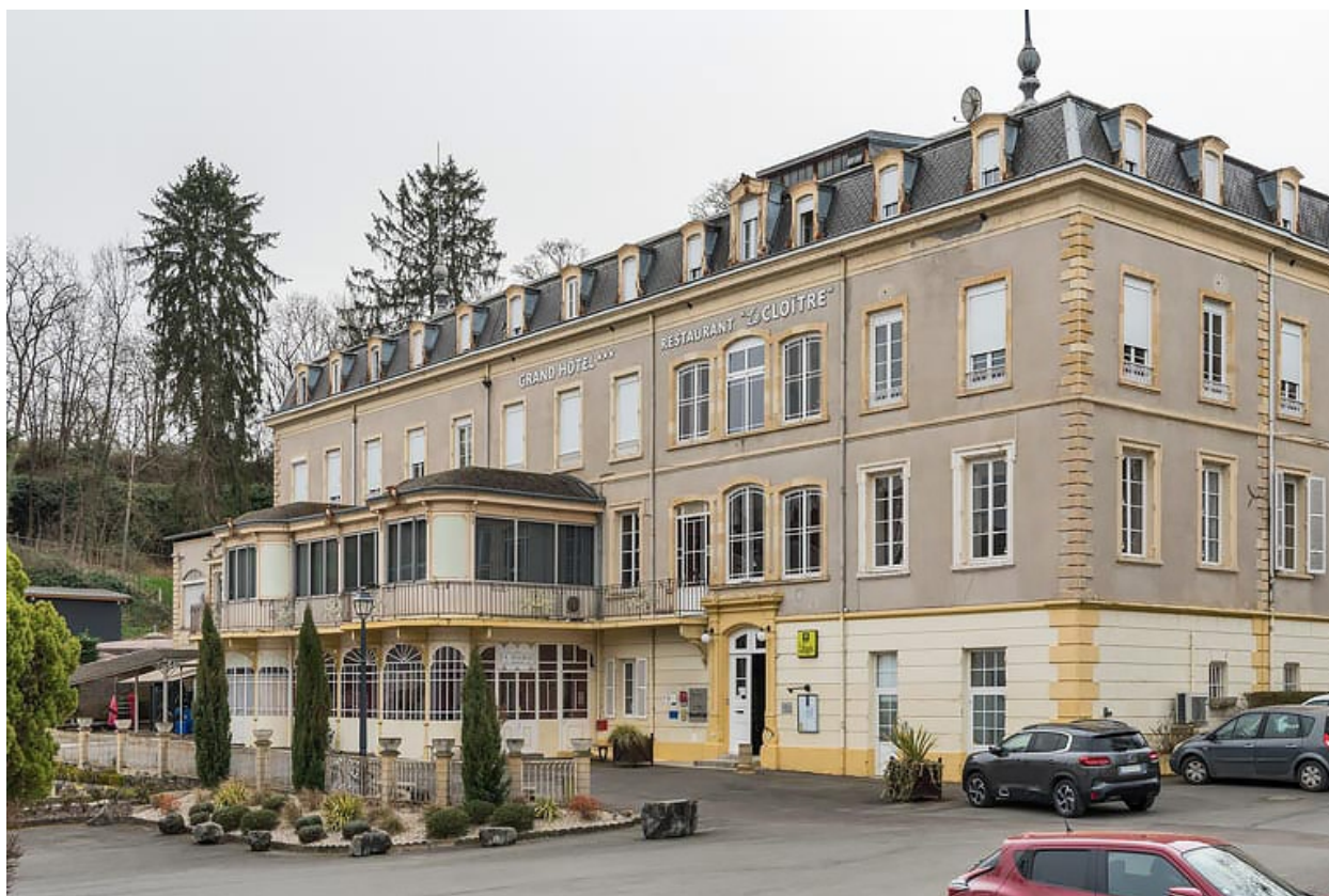
Aile ouest, façade.
