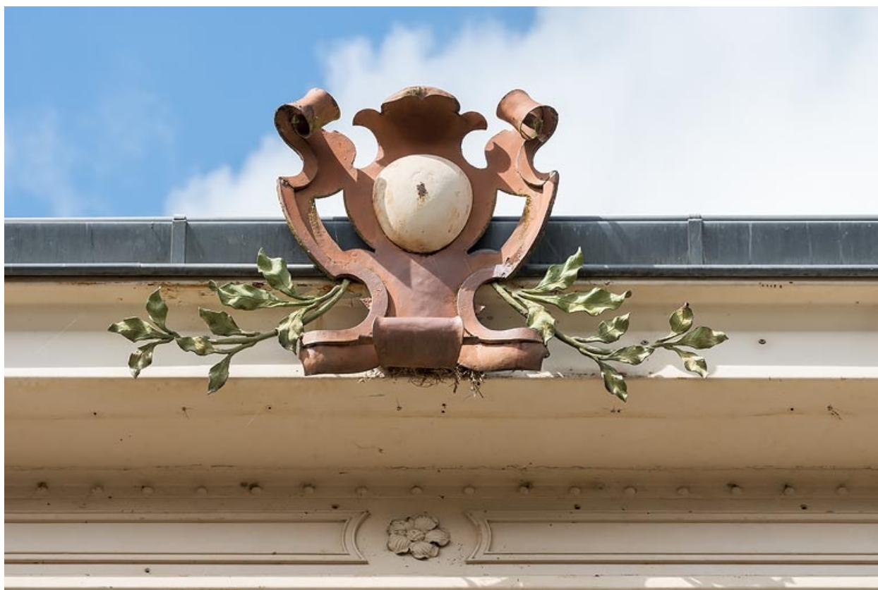
Aile ouest, salle à manger, détail.
