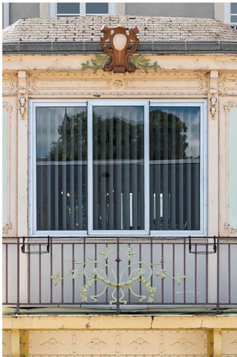
Aile ouest, salle à manger, détail.
