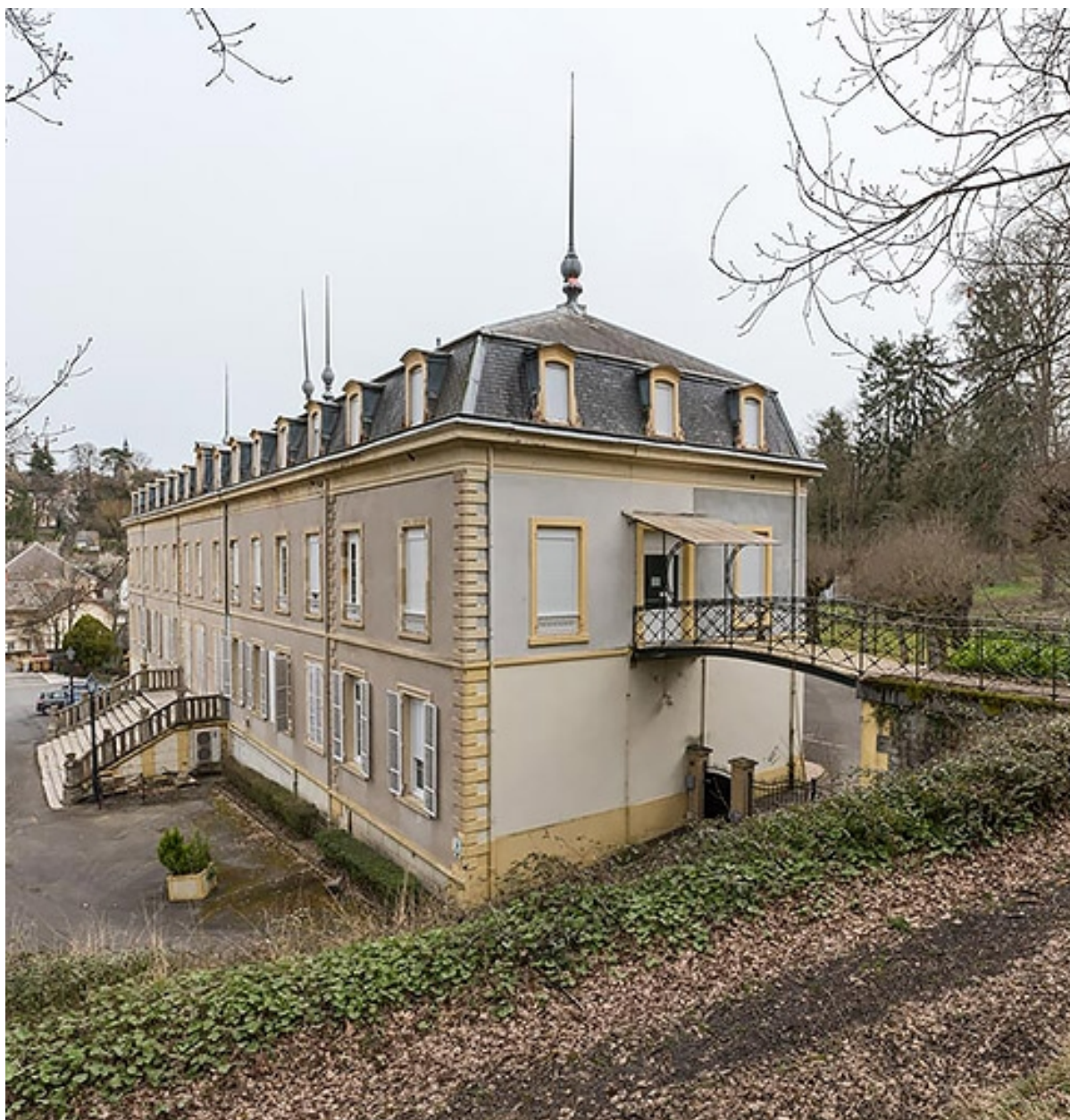
Aile nord, vue d'ensemble.
