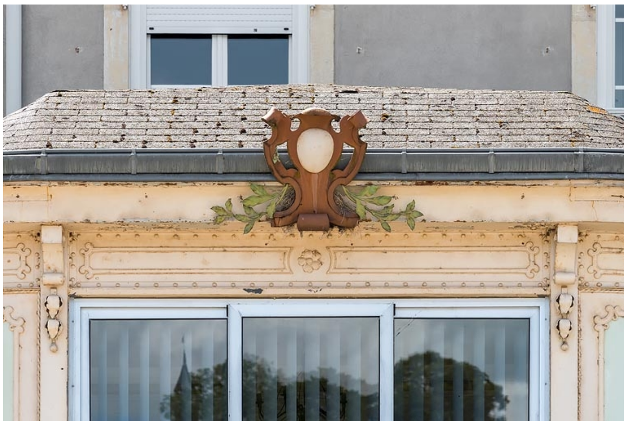
Aile ouest, salle à manger, détail.
