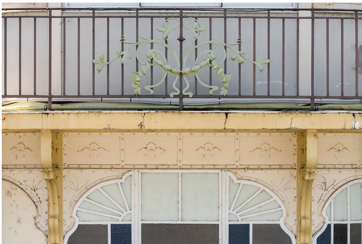
Aile ouest, salle à manger, détail.
