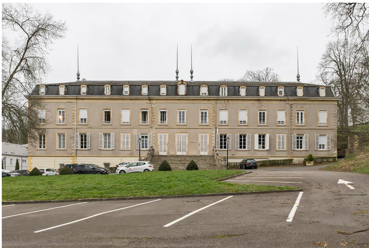
Aile nord, façade.
