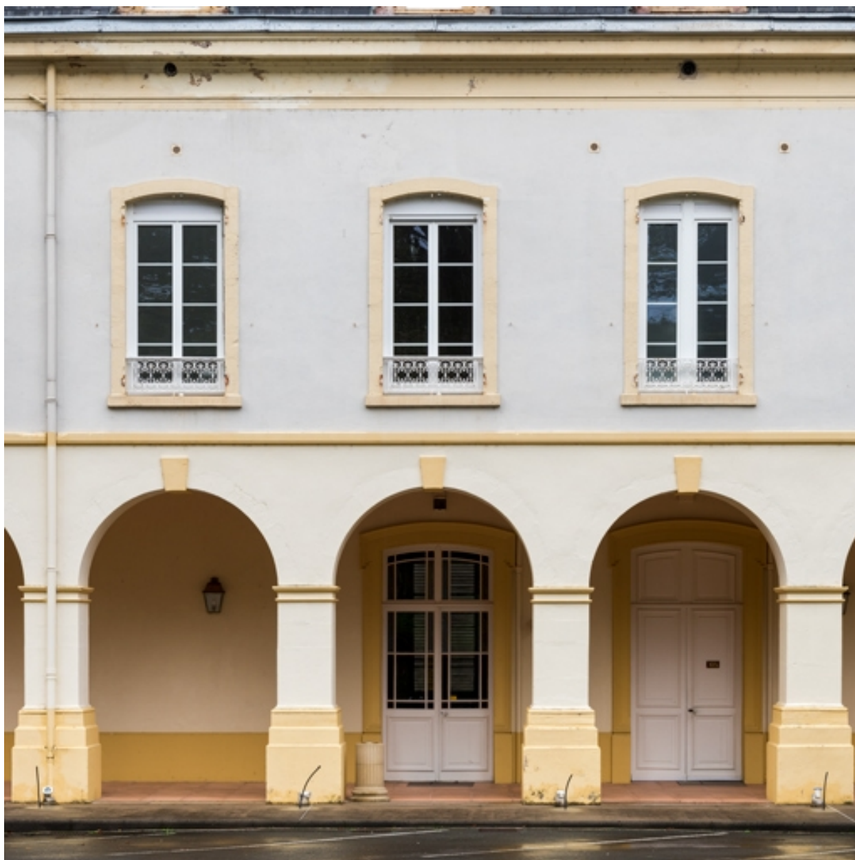
Cour, détail de l'aile nord.
