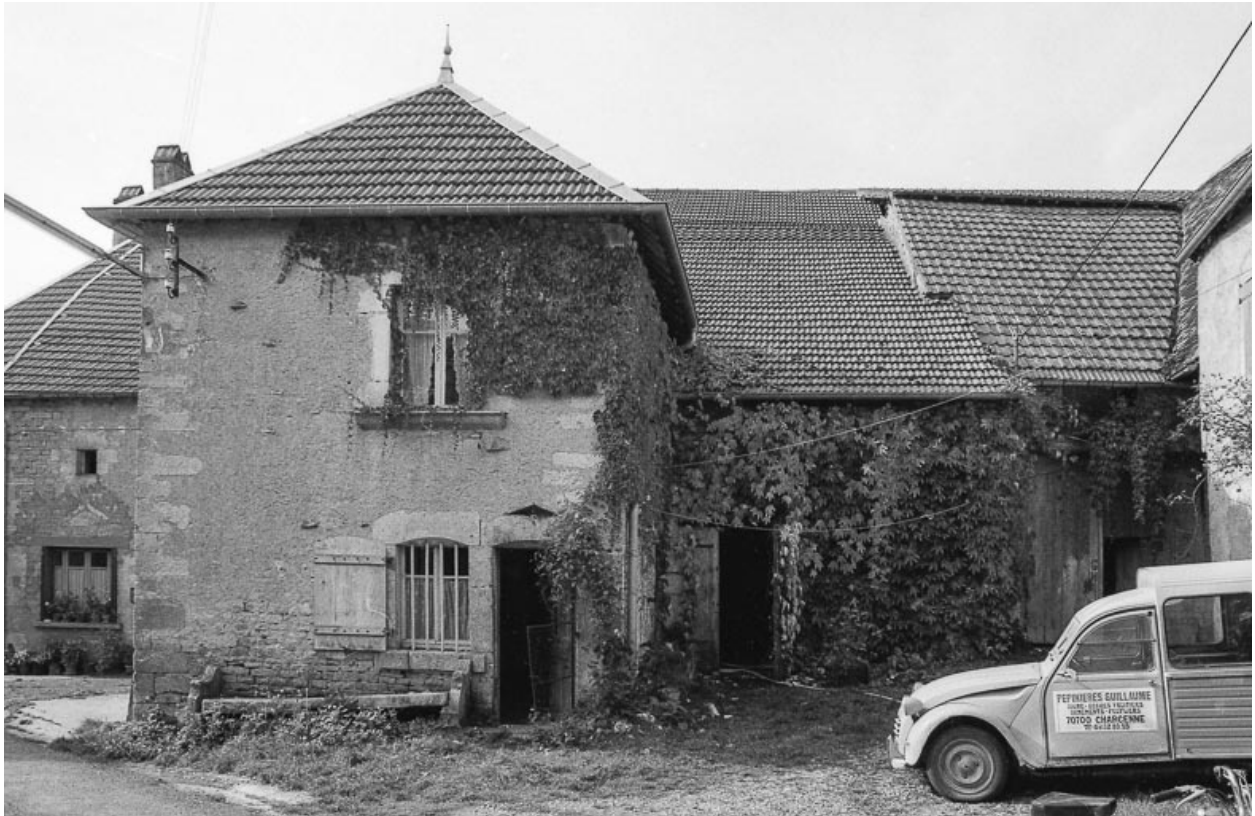
Ferme cadastrée 1958 C3 703 : façade antérieure.
