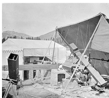
[Cistierna. Vue d'ensemble rapprochée de l'installation Hamy], 1905. Phot. Yves Sancey IVR43_20042500136XI
