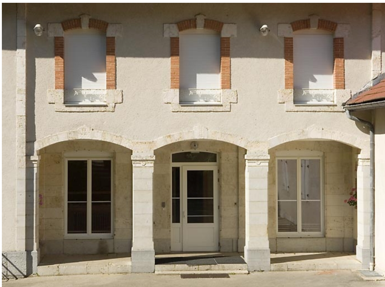
"Grand Château" : baies sur la façade antérieure.
