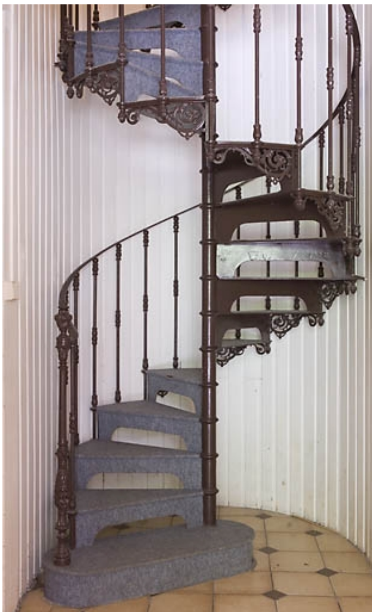
"Grand Château" : escalier métallique en vis.
