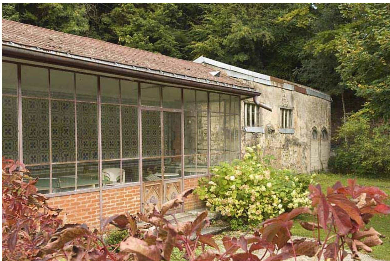
Serre et garage, vus de trois quarts.
