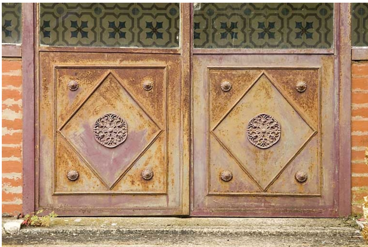
Serre : ferronnerie de la porte.
