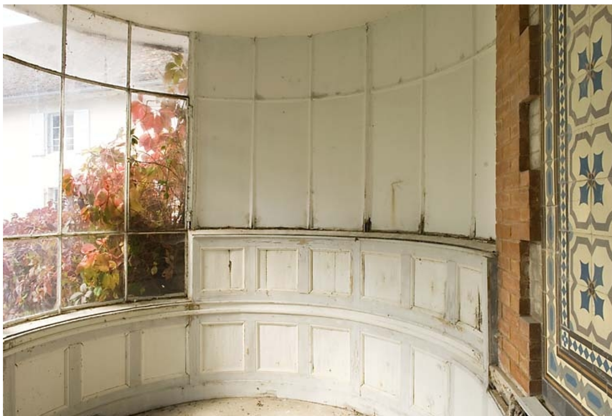
Serre : intérieur (extrémité nord-ouest).
