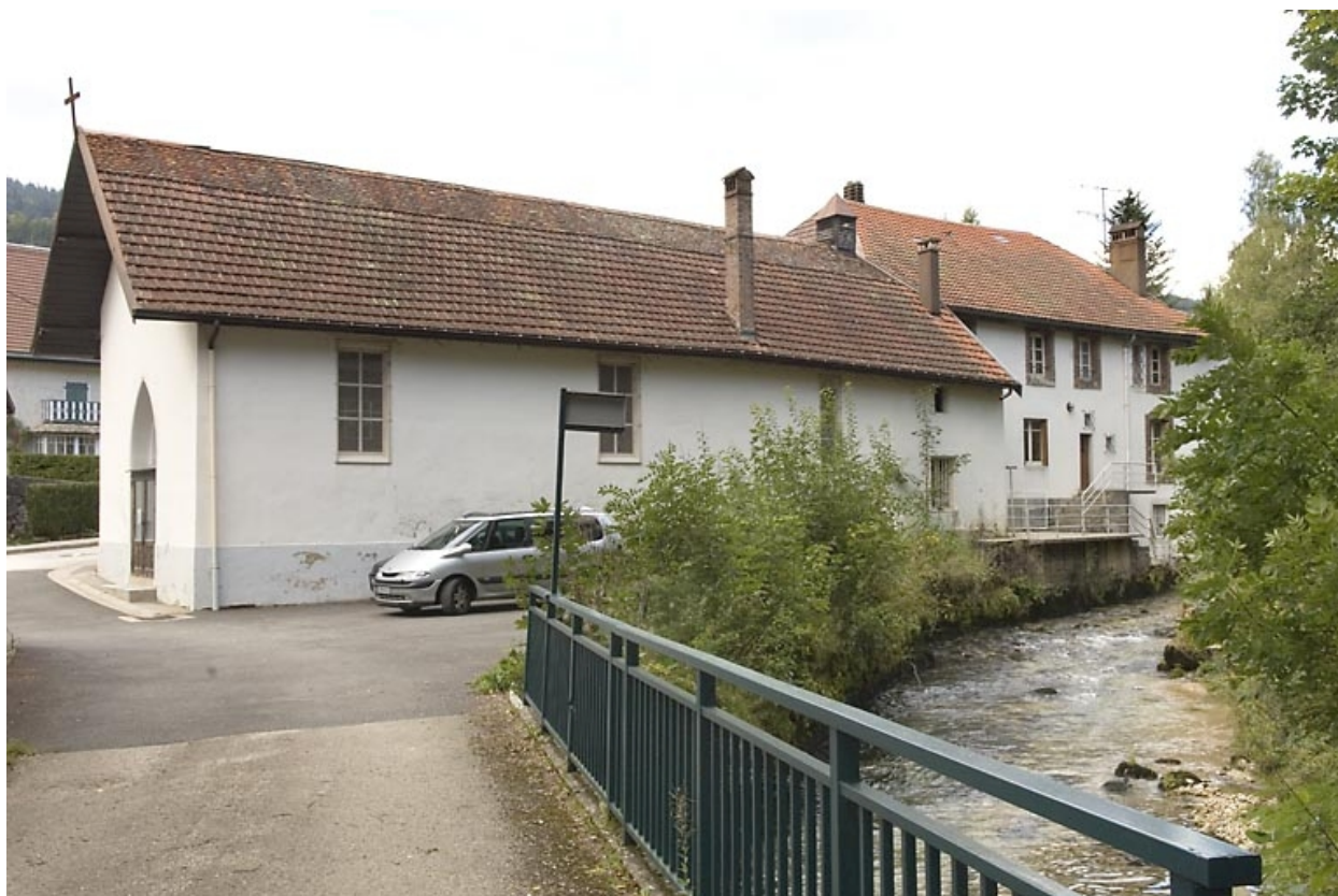
Chapelle rue des Forges : façade latérale droite.
