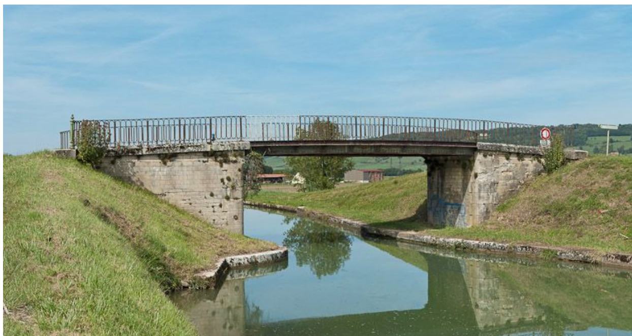
Vue du pont.
