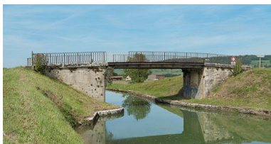
Vue du pont.
