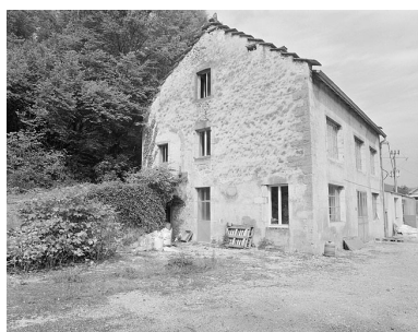
Façade antérieure et face gauche du moulin. Phot. Jérôme Mongreville IVR43_19973900829X
