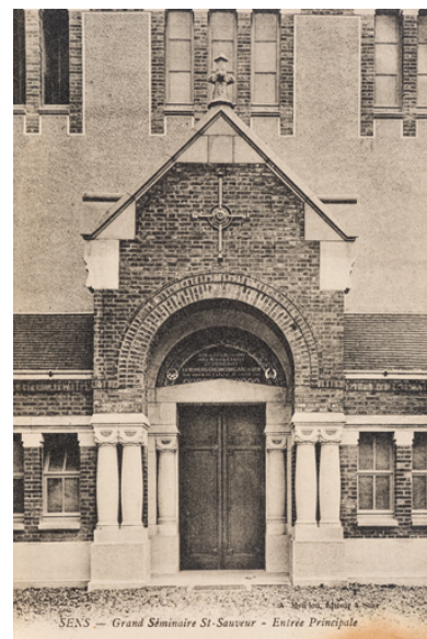
Détail de l'entrée principale, entre 1921 et 1934.
