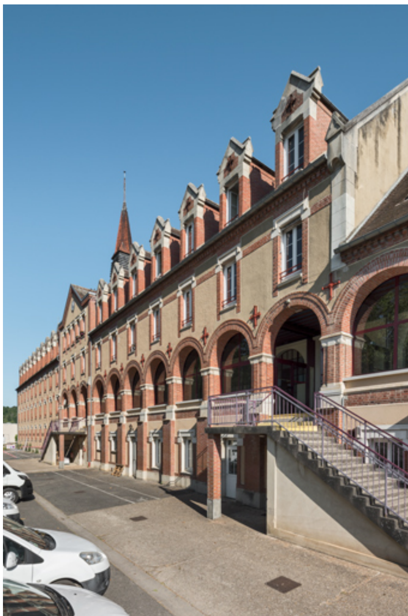
Vue de la façade sud (de trois-quarts).
