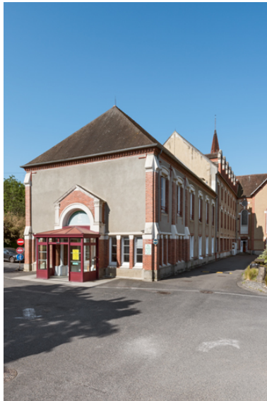
Vue des façades nord et est.
