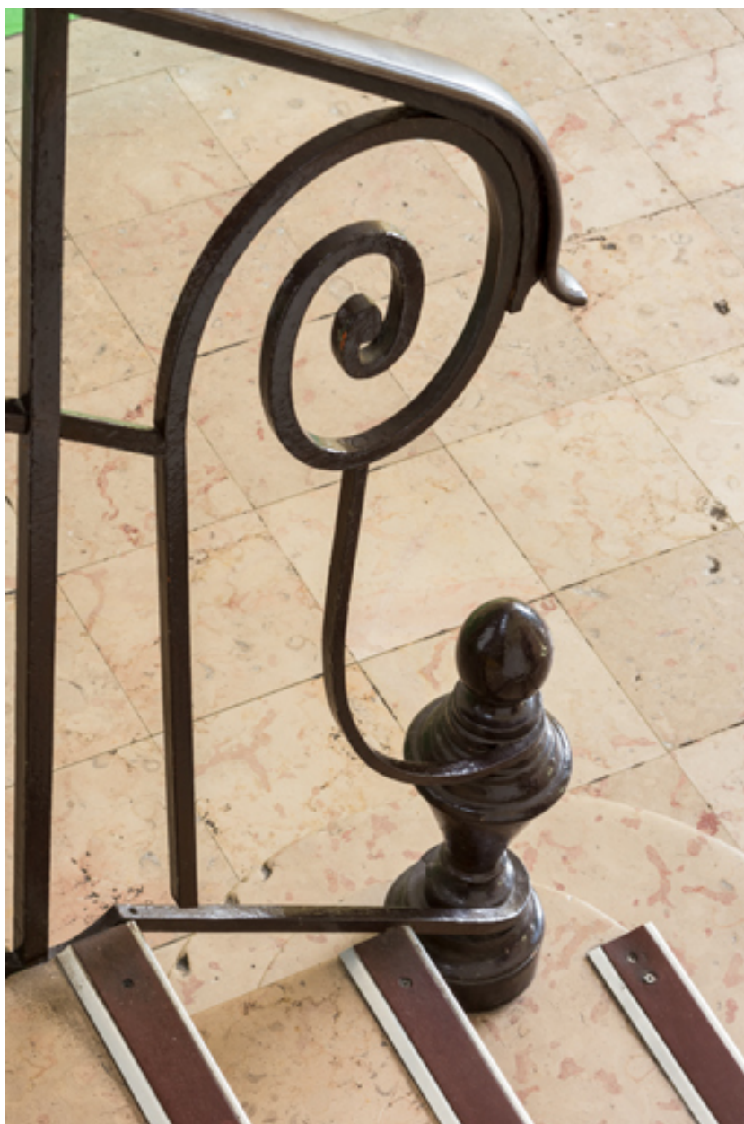
Détail du garde-corps de l'escalier.
