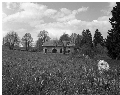
Vue éloignée de la ferme dans le site. Phot. Jérôme Mongreville IVR43_20013900532X
