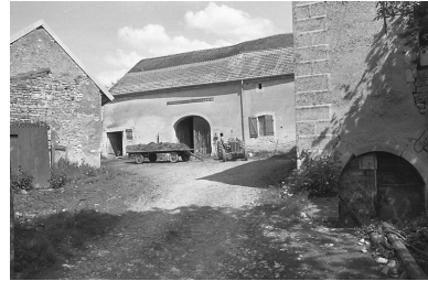
Vue des parties agricoles depuis la cour. Phot. Bernard Lardière IVR43_19817000336Z
