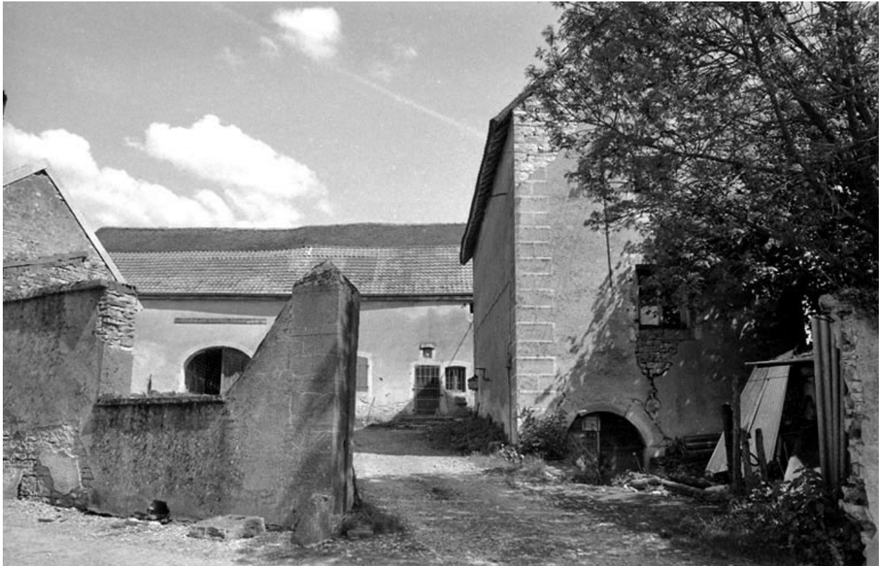
Vue d'ensemble depuis l'entrée de la cour.
