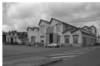
Fonderie (construite en 1928), vue du Sud Est. Phot. Frédéric Pillet IVR26_19997100034Z
