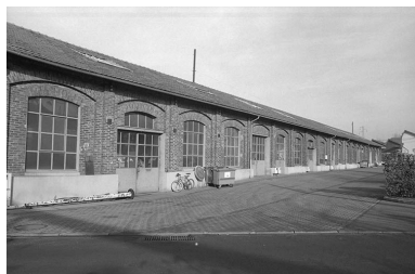
Charpenterie et charronnerie vues de l'est. Phot. Frédéric Pillet IVR26_19997100029Z
