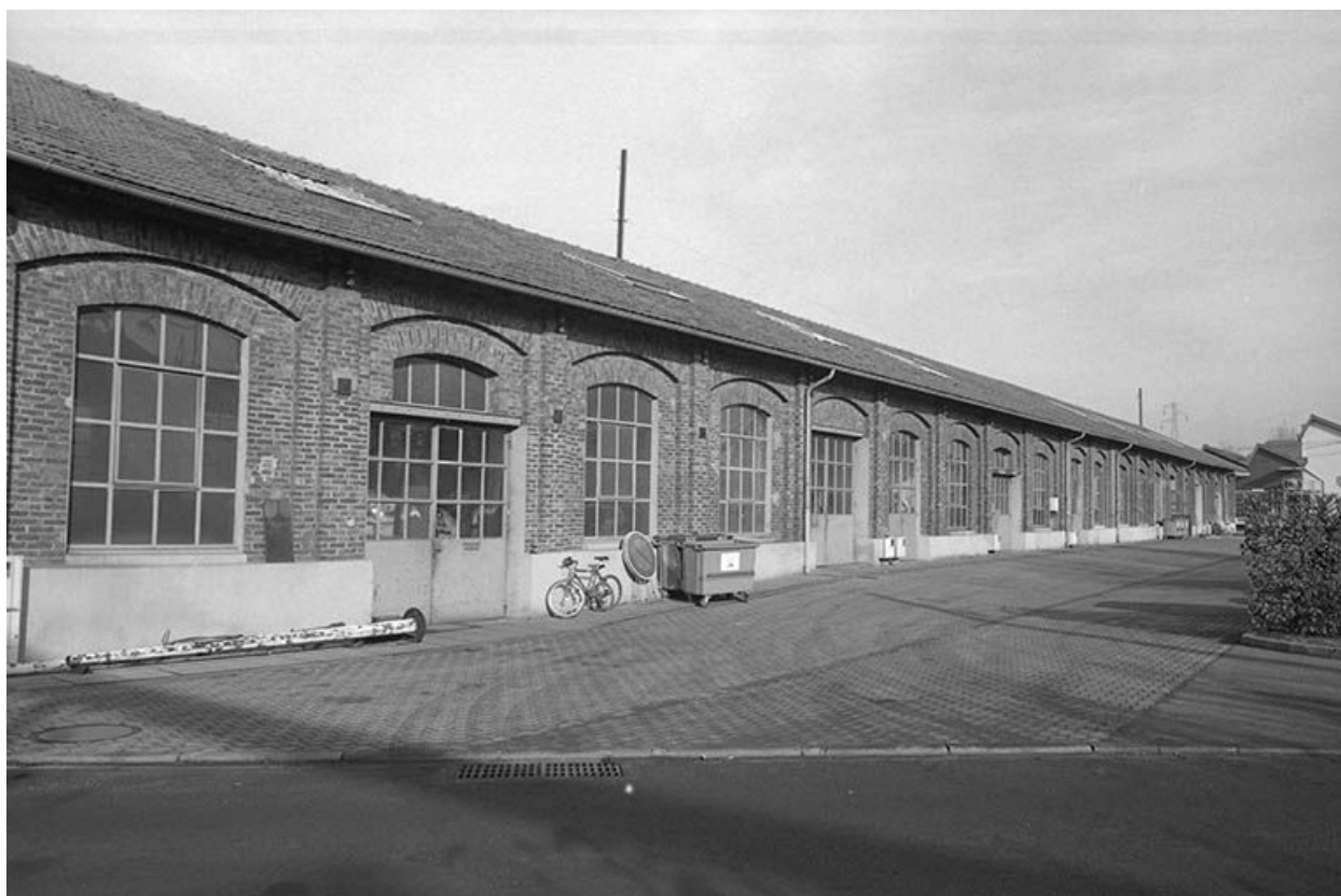
Charpenterie et charronnerie vues de l'est.
