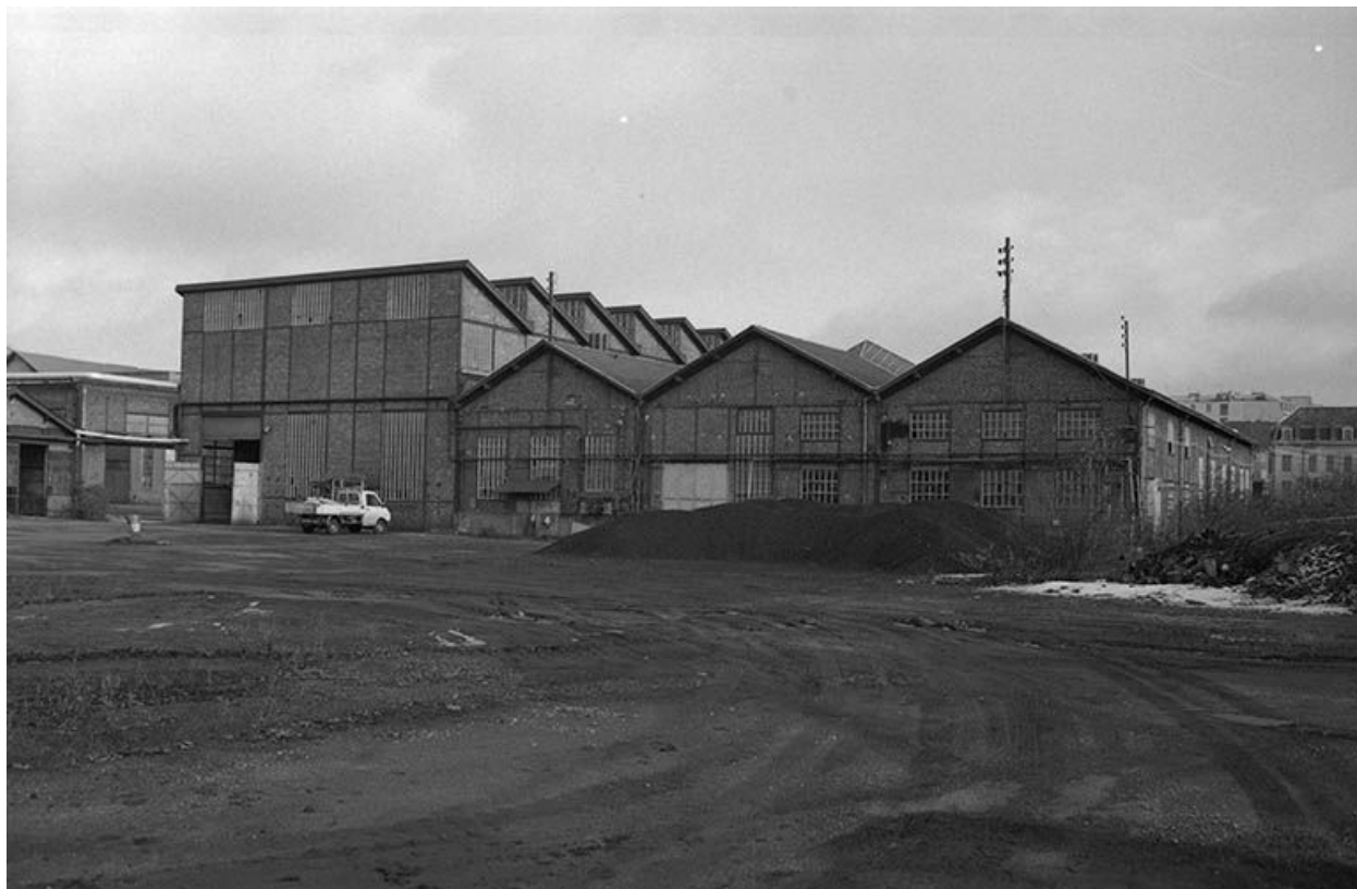
Chaudronnerie vue de l'Ouest.
